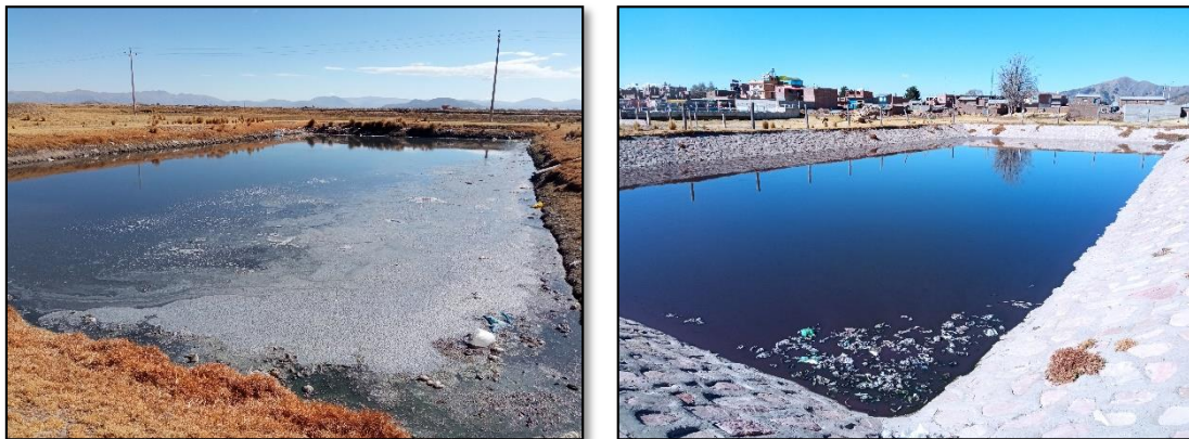
Figura N° 22: Estado actual de la laguna primaria y secundaria
