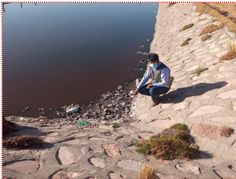
Fotografía N° 10: Se observa natas y plásticos en la salida de la laguna secundaria de la PTAR del distrito de Taraco
