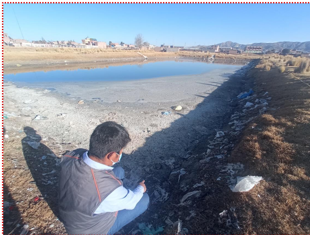
Fotografía N° 06: Se observa la colmatación de lodos de la laguna primaria de la PTAR del distrito de Taraco
