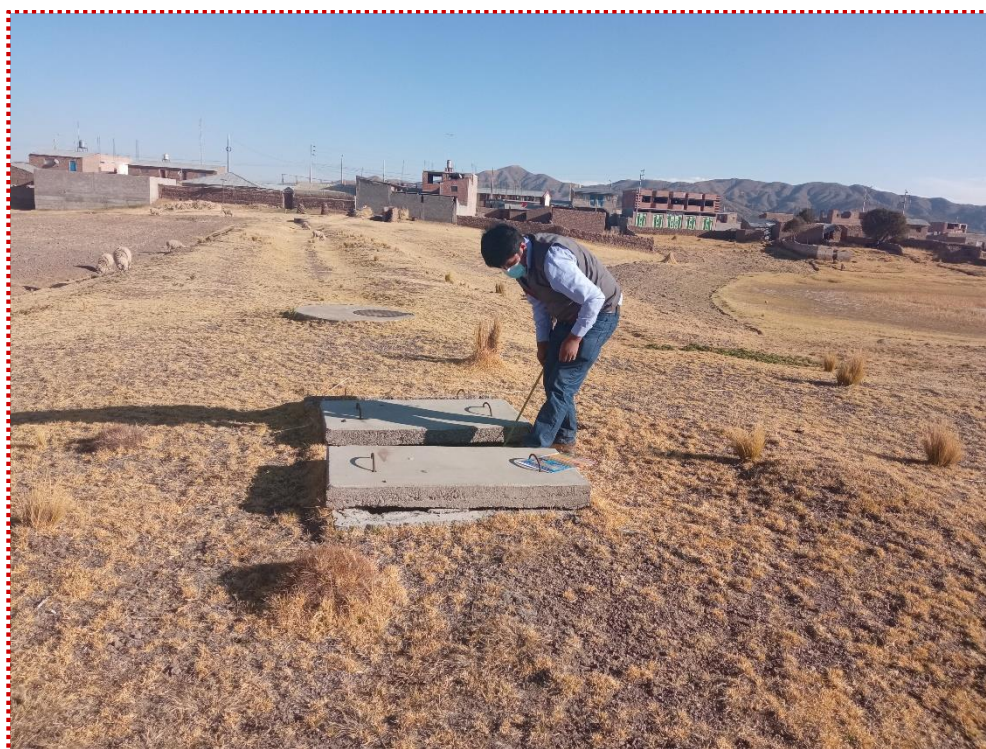
Fotografía N° 02: Se observa la cámara o canal de entrada a la PTAR
