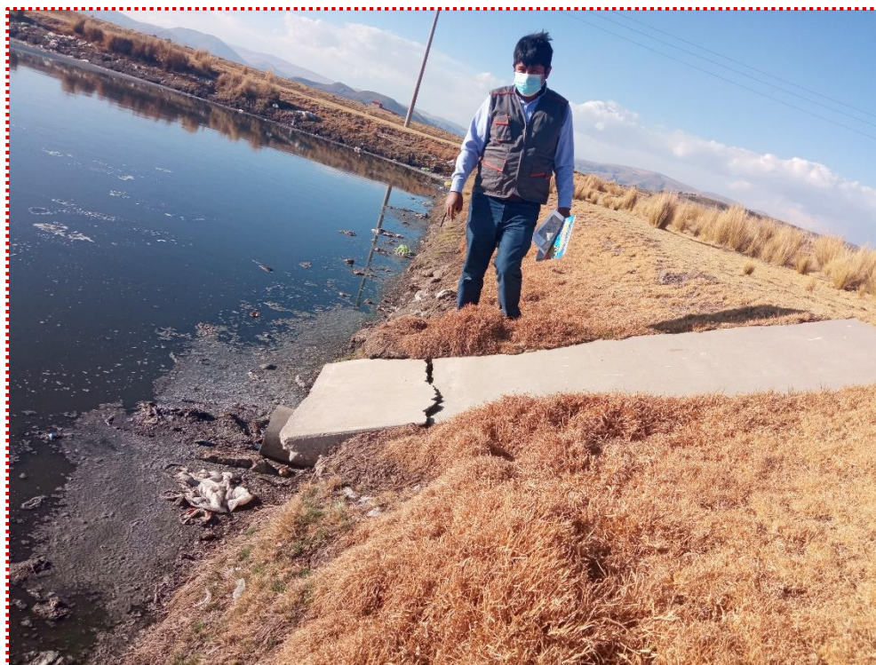
Fotografía N° 06: Se observa la colmatación de lodos de la laguna primaria de la PTAR del distrito de Taraco
