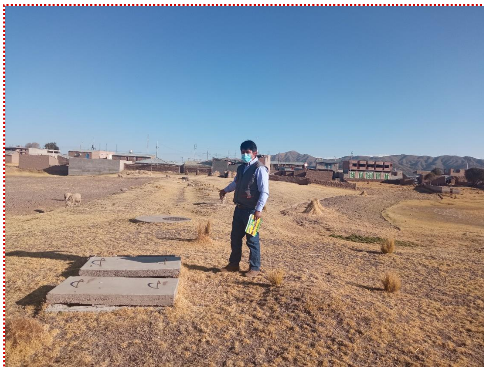
Fotografía N° 01: Se observa la cercanía de la PTAR con respecto a la población
