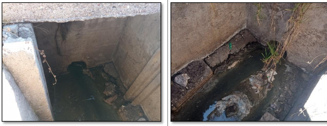
Figura N° 20: Estado actual del canal de entrada
