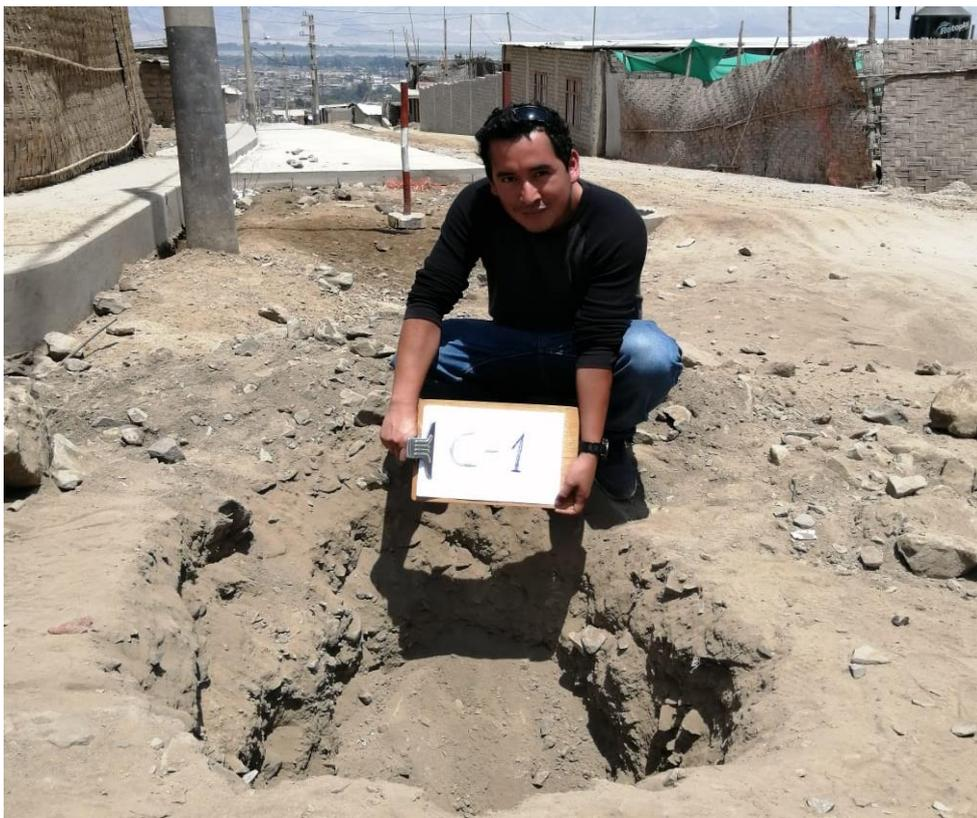
Figura 38: realizamos la excavación del terreno, calicata 1.
