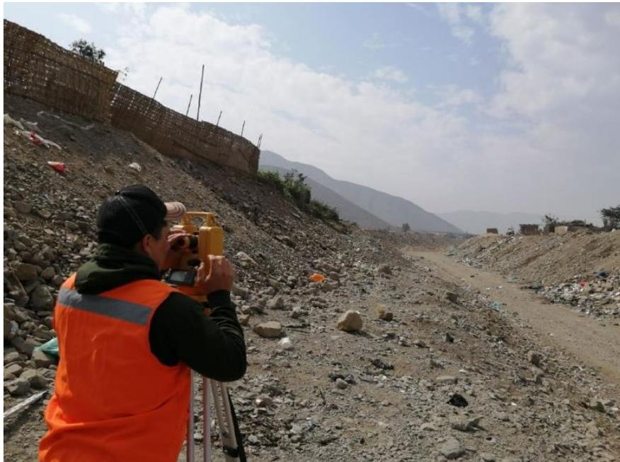
figura 42: Trazo topográfico de tramo de la quebrada
