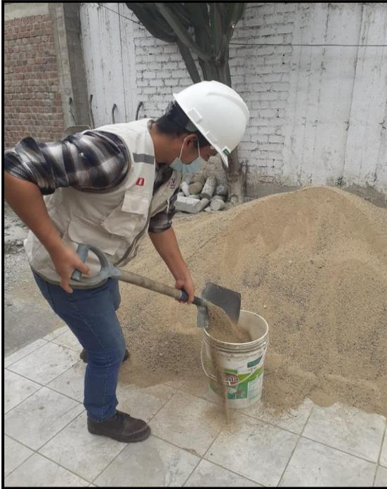
FIGURA 23. Llenado de material para pesar de acuerdo a los pesos para diseño de mezclas  $f'_{cr} = 294\text{kg/cm}^2$ .
