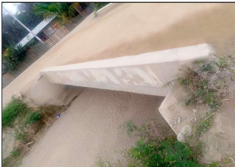
Foto 4. Tramo a ejecutar el proyecto
