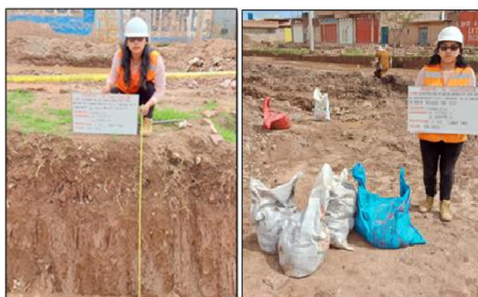
Figura 1. Vista de la calicata y Obtención de muestras Fuente: Elaboración propio
