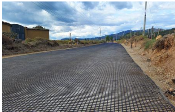
Figura 7. Instalación de geomallas biaxiales.
