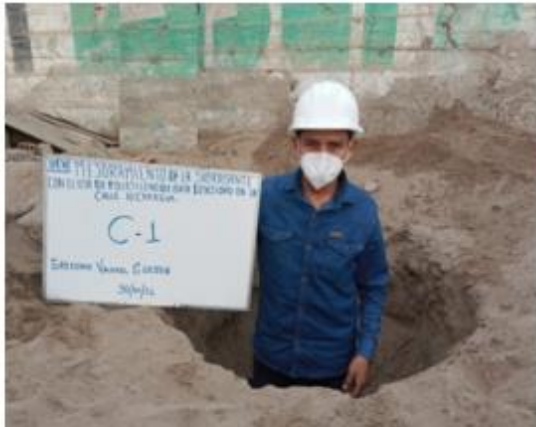
Fotografía 1. Excavación de C-1.
