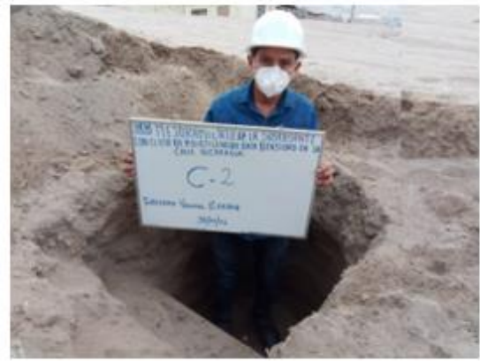
Fotografía 4. Excavación de C-2.
