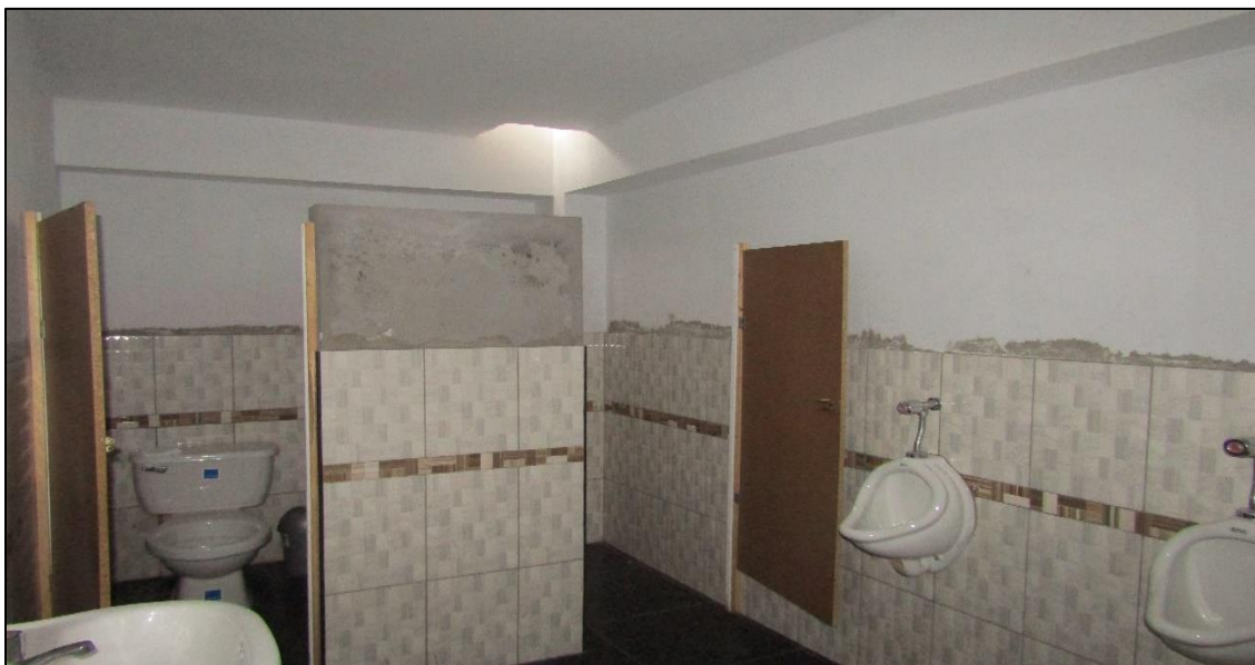
Figura 49. Servicios higiénicos de la empresa completamente limpios
