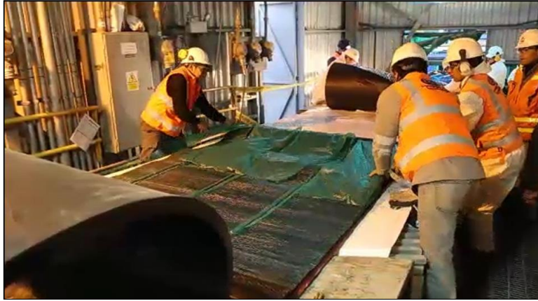
Figura 58. Colocación de cover de Retorno.
