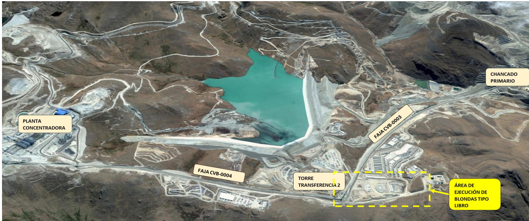
Figura 43. Área de ejecución de blondas tipo libro
