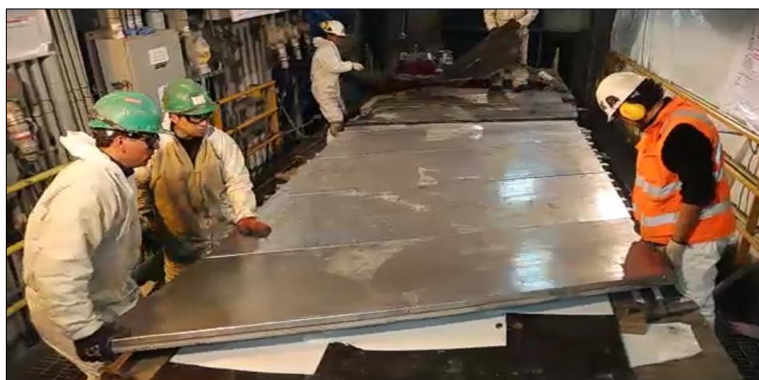
Figura 66. Colocación de Platos Calefactores.
