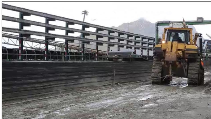
Figura 76. Jalado de Faja con winche 20 ton.
