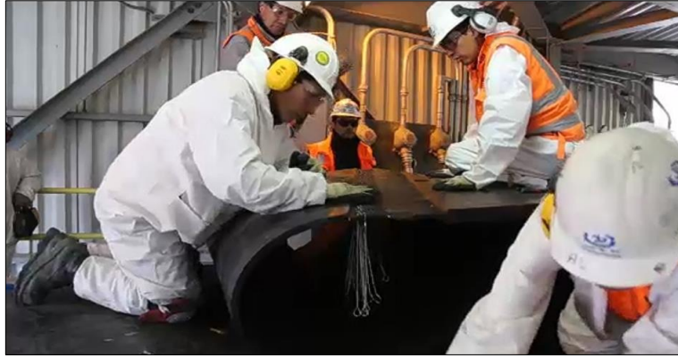
Figura 49. Colocación de las cuerdas de piano.
