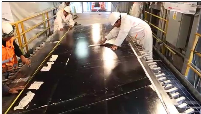
Figura 74. Vista de Empalme Terminado
