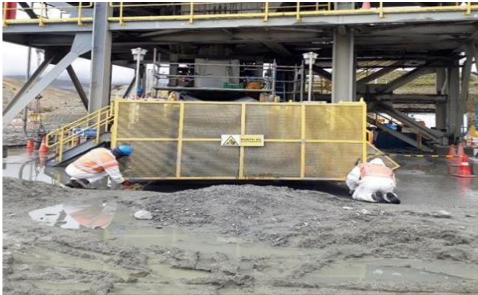
Figura 88. Imagen de retiro de guardas
