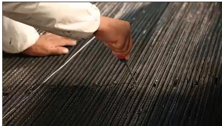
Figura 60. Relleno de cortes.
