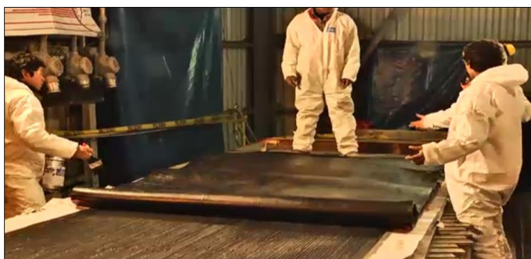
Figura 63. Cemento vulcanizante en cover de carga
