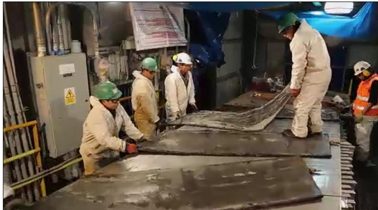
Figura 67. Colocación de Bolsas de Presión.
