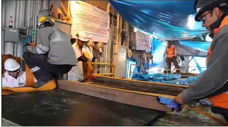
Figura 57. Colocación de eslingas y tacos.
