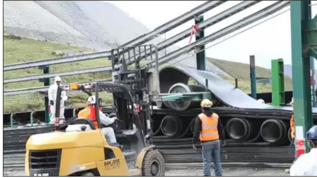
Figura 75. Colocación del tambor jalador para faja empalmada
