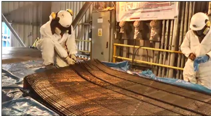
Figura 52. Retiro de cover de retorno
