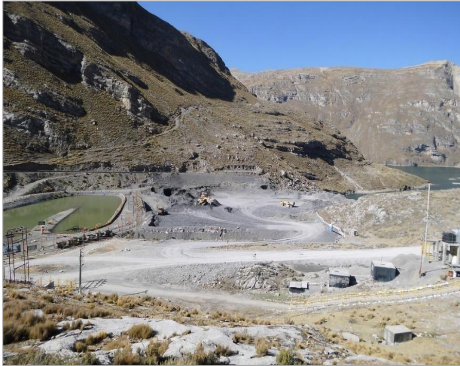
Figura 18: Vista panorámica de la poza de sedimentación
