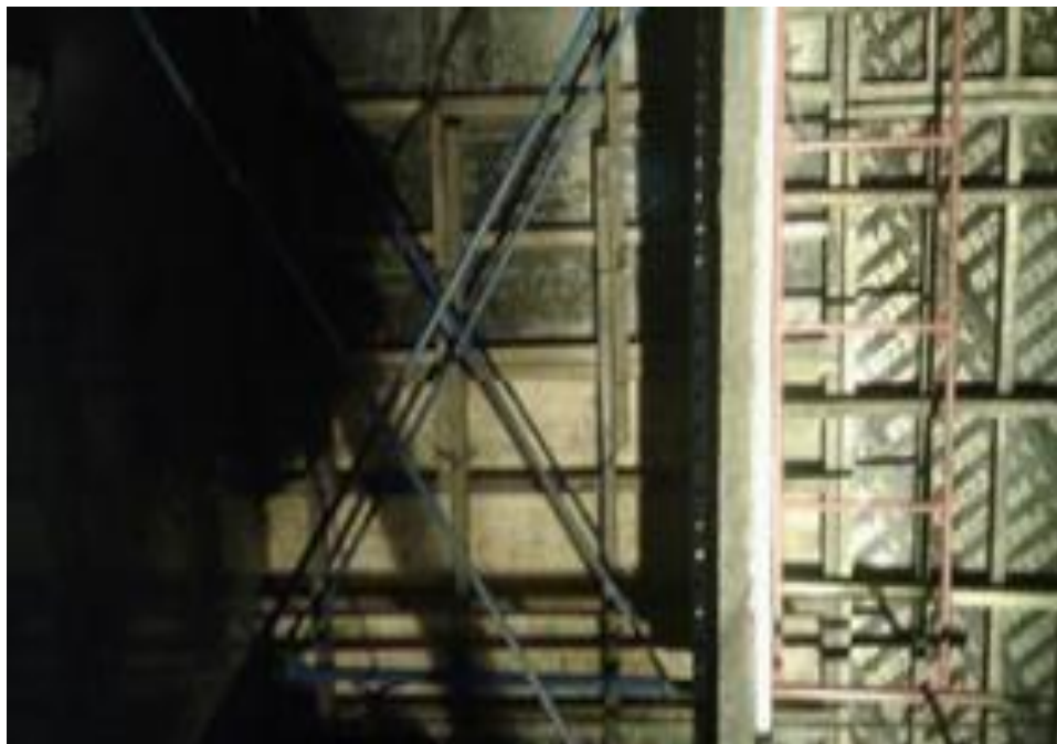
Figura 37: Enfierrado y encofrado del Muro a la altura del proyecto
