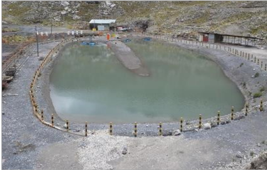
Figura 16: Poza de sedimentación de los efluentes que salen de interior mina por la bocamina Huantajalla
