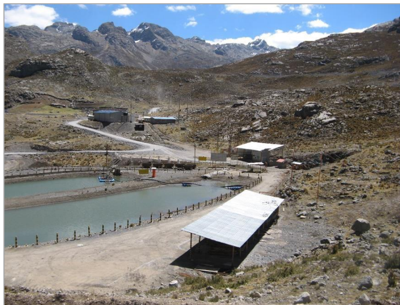
Figura 17: Vista lateral de la poza de sedimentación ubicada frente a la bocamina de Huantajalla
