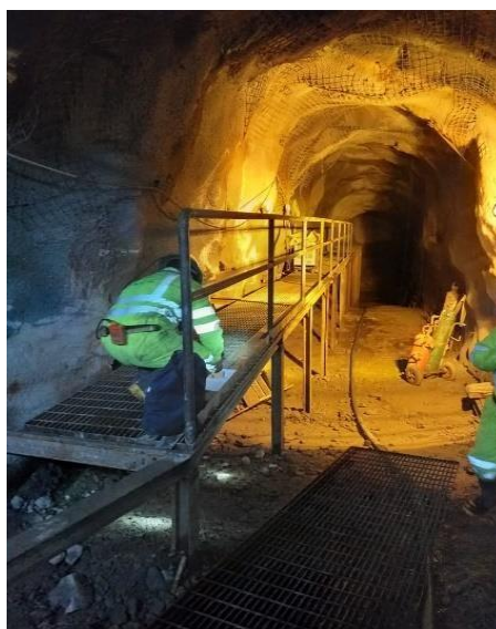
Figura 39: instalación del pasamanos
