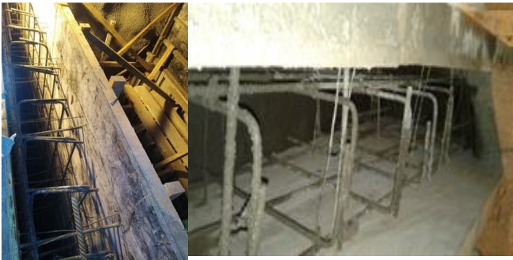
Figura 35: Enfierrado y encofrado de la zapata del muro
