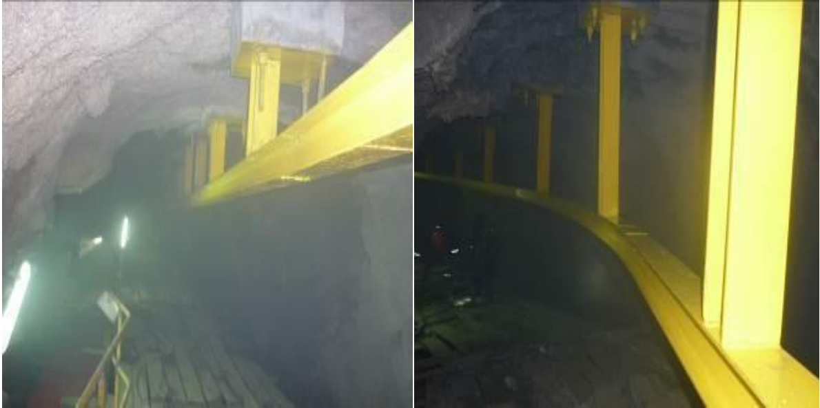
Figura 42: Montaje del monorriel para reparación y mantenimiento de la Bomba Tsurumi
