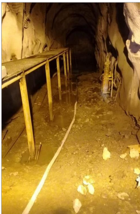
Figura 38: Colocación de los soportes de la Passarella
