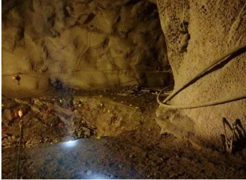
Figura 34: Perforación para las Zapatas y perforación de taladros de servicios para colgar la tubería de 4”
