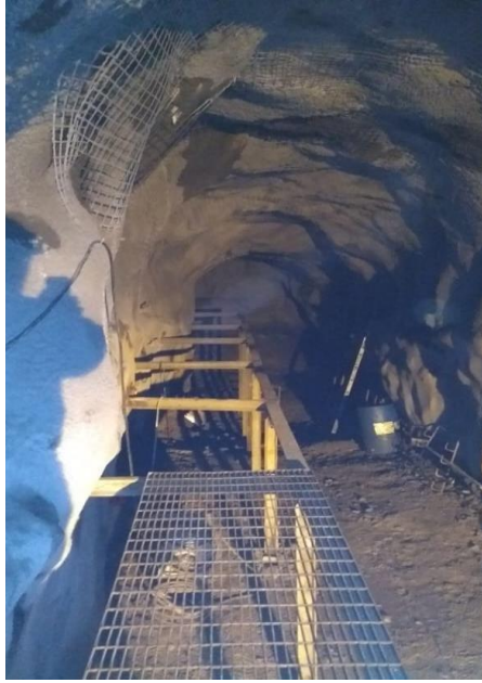
Figura 40: Colocación de la parrilla greating sobre los soportes de la Pasarela
