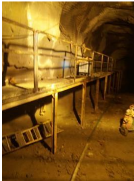
Figura 41: Pintado y acabado de la Pasarela
