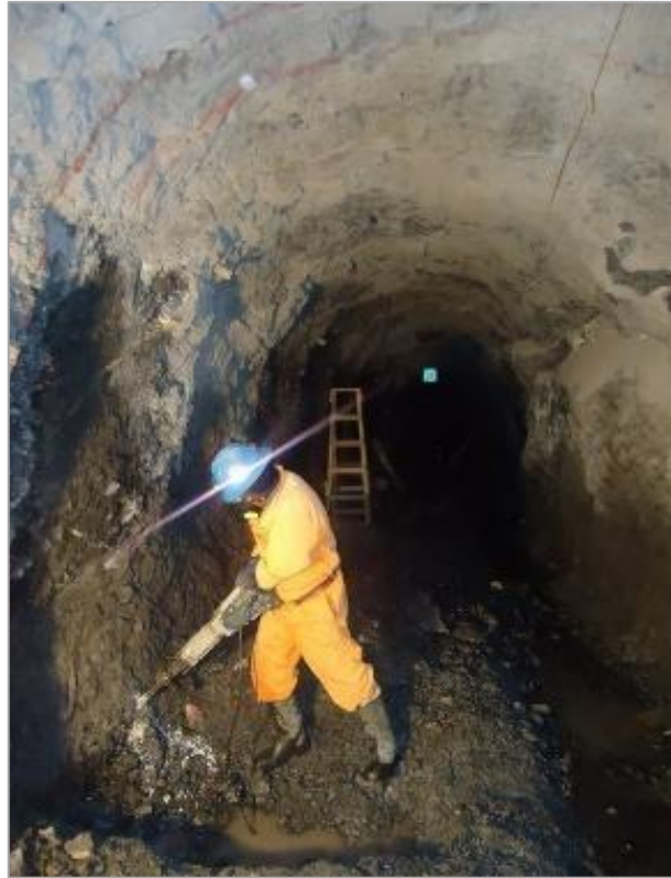
Figura 31: Perforación para realizar el desquinche y ampliar la sección
