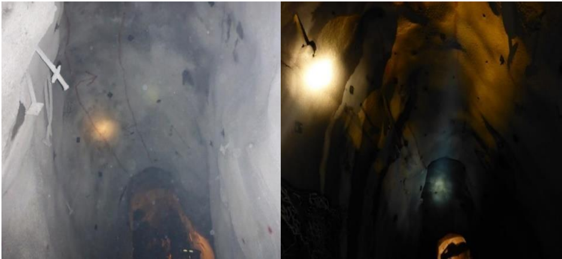
Figura 33: Se evidencia el sostenimiento con malla más Split set y las 2 pulgadas de Shotcrete en el acceso 1 y 2 de la poza
