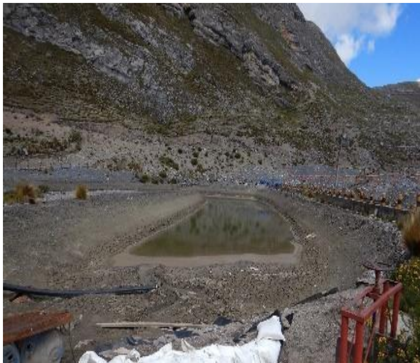
Figura 45: Se evidencia que ya no hay ingreso de agua a la poza de sedimentación
