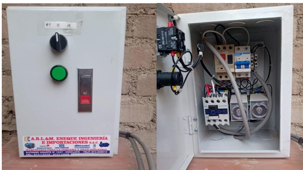
Figura N° 17: Instalación de la caja metálica.
