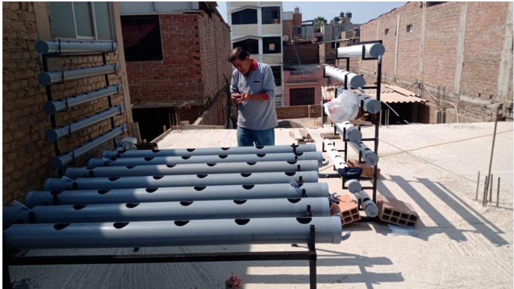
Figura N° 15: Instalación de la bomba de agua.
