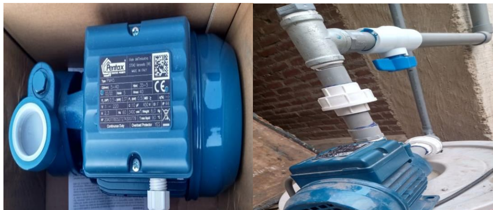
Figura N° 14: Instalación de la bomba de agua.
