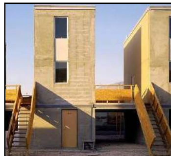
QUINTA MONRROY, acceso a segunda vivienda Fuente: https://archdaily.pe
