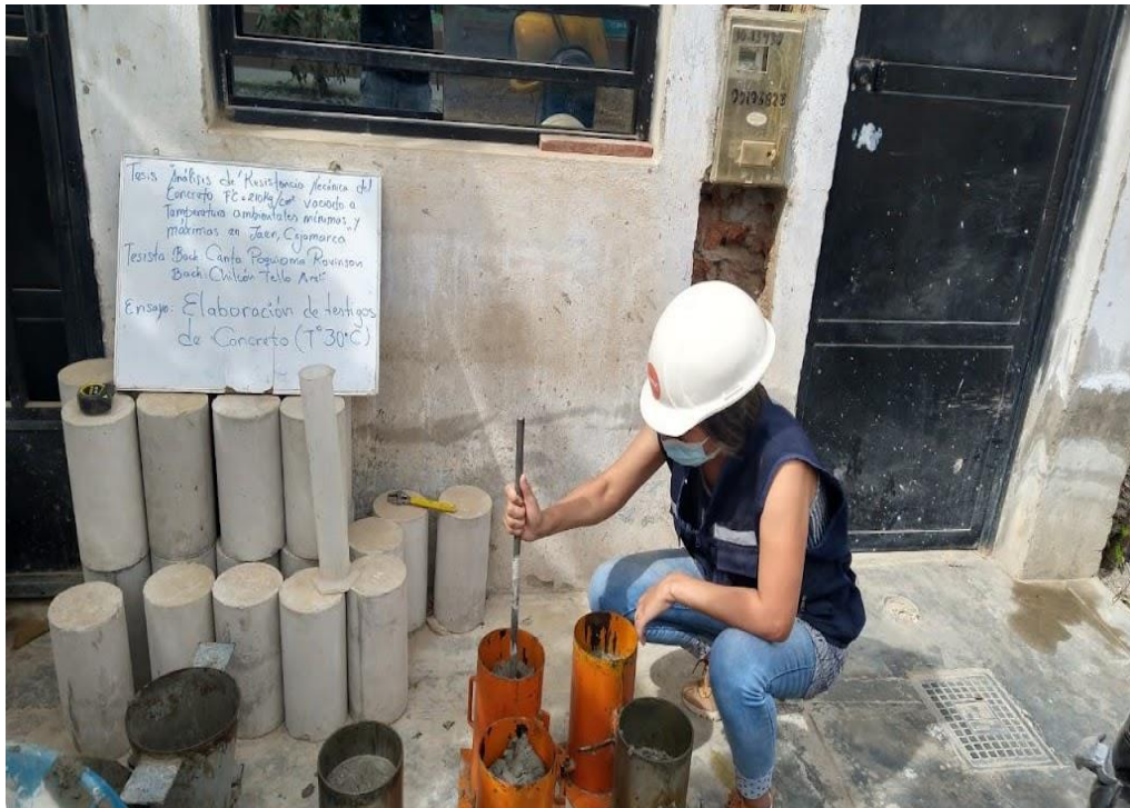
Figura 14. Vaciado de probetas de concreto a temperatura ambiental de 30 °C.
