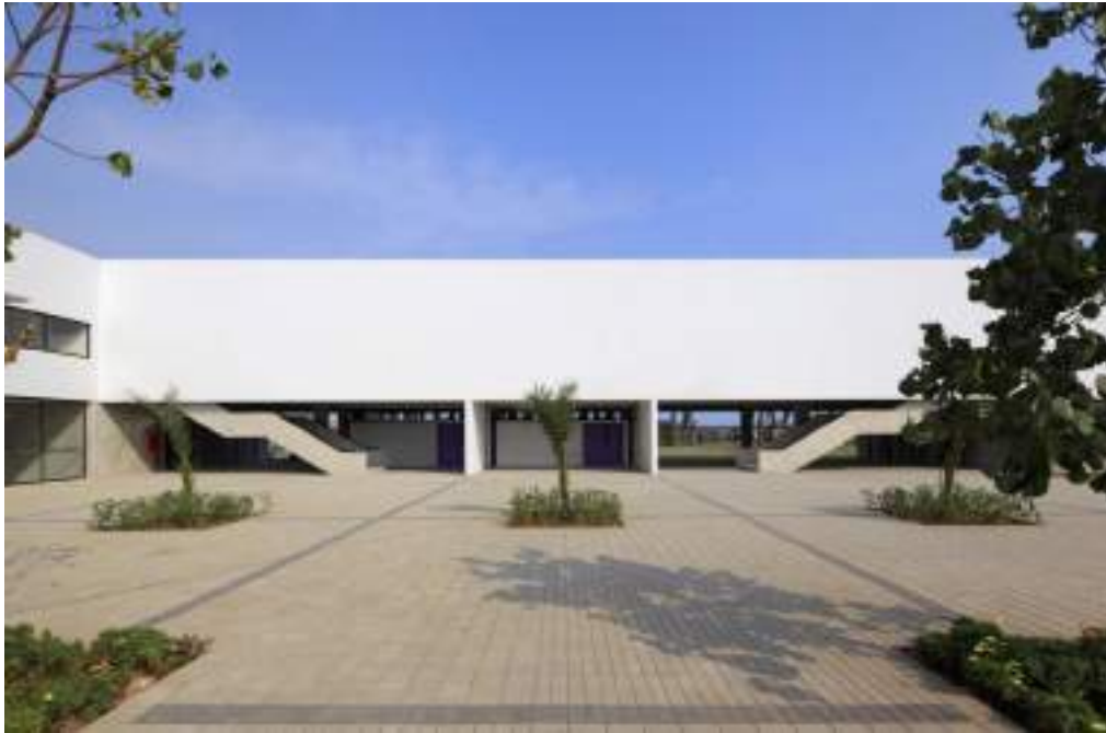
Figura 4. Vista de patio interior colegio LVC.
