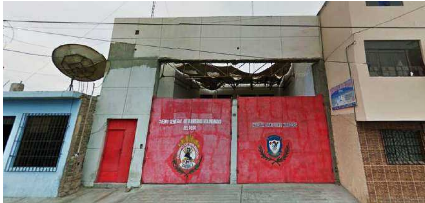
Figura 61: Estación de Bomberos de Pisco / Google Maps
