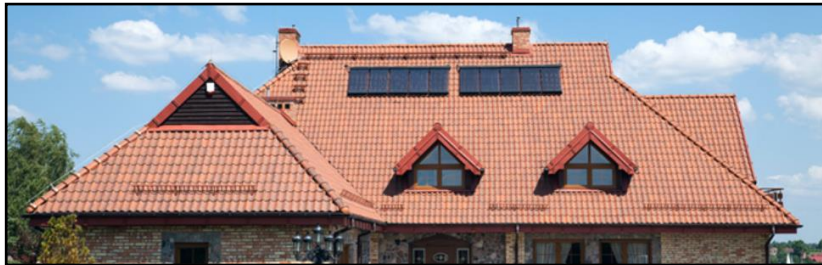
Figura N°12: Cubierta adecuadamente establecida que avala un comportamiento de diafragma rígido.
