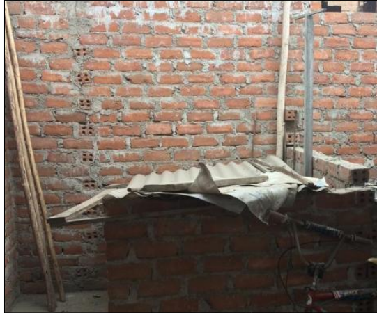
Figura N°26: Muro de ladrillo artesanal
