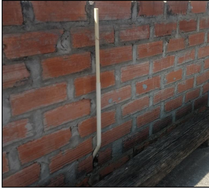
Figura N°49: Elementos no estructurales
