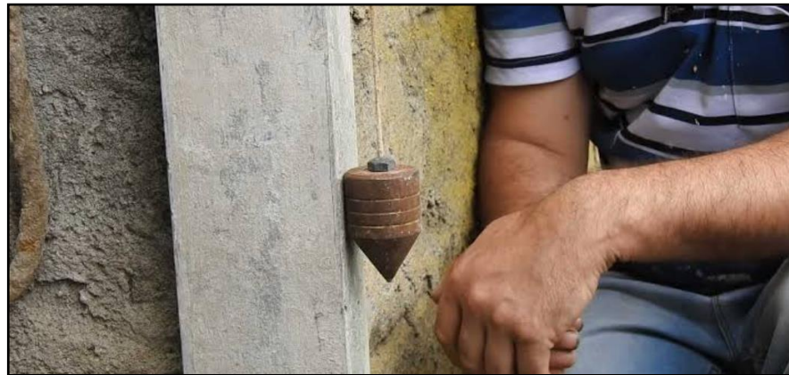
Figura N°06: aplomo entre unidades de albañilería.
