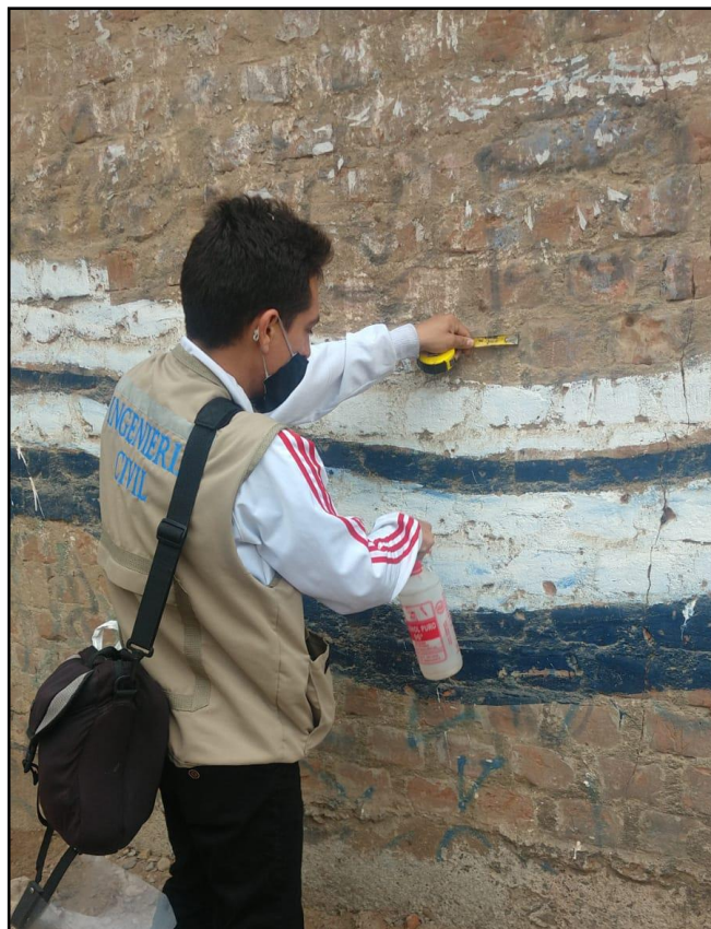
Figura N°44: muros con asentado de ladrillo de soga.
