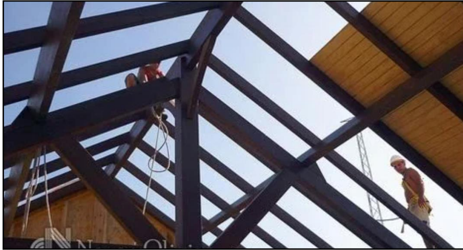
Figura N°13: adecuada ubicación de las vigas de soporte para la cubierta.
