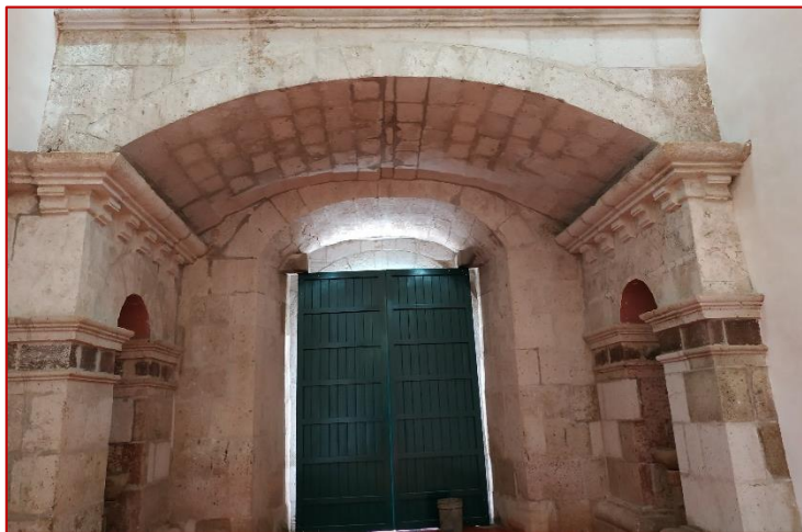
Figura 19: Vista del sotocoro
