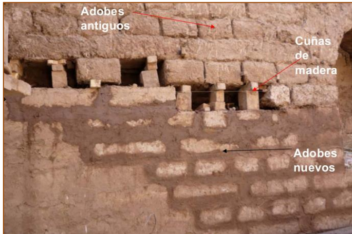
Figura 51: Reconstrucción de muros de adobe
