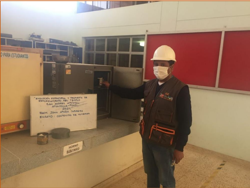
Fig. 2.- Contenido de humedad
