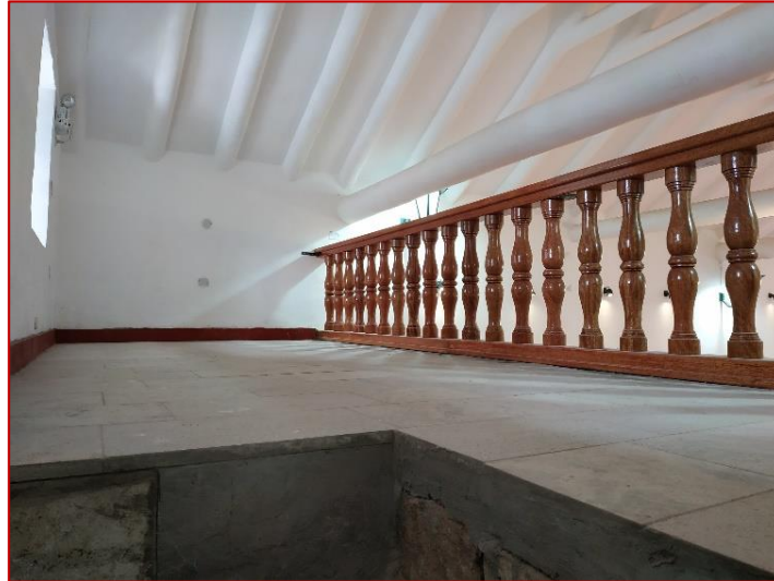
Figura 20: Vista del coro
