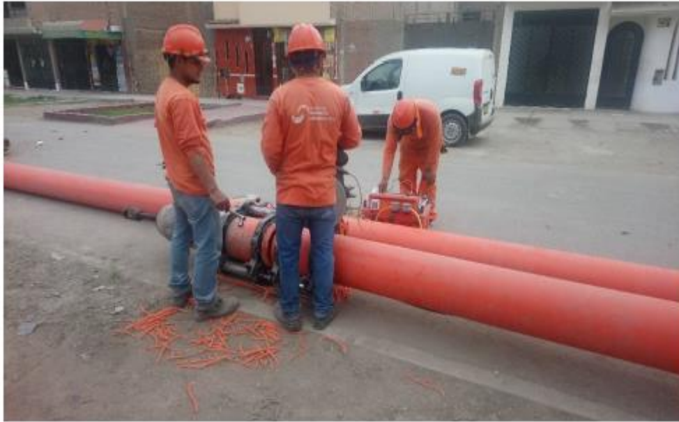
Figura 16: Proceso de Termofusión de Tuberías
