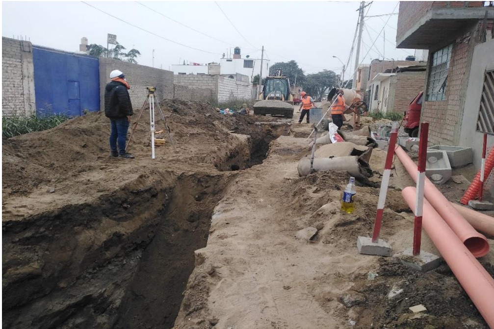
Figura 14: Trazo y replanteo durante la Obra (Método Tradicional)
