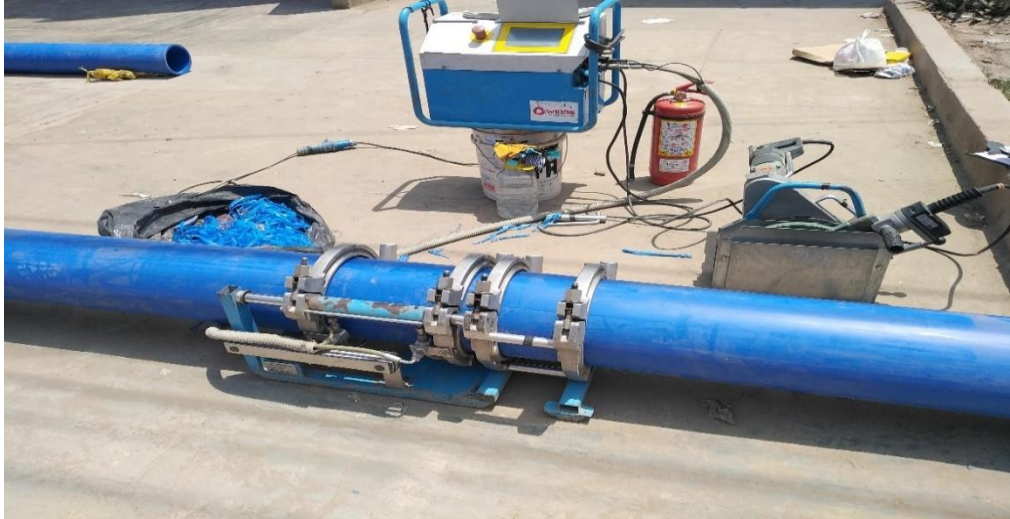
Figura 06: Termofusión de Tuberías de HDPE para método Cracking
