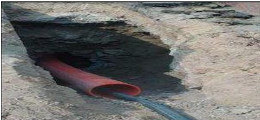
Figura 07: Suelo favorable para la instalación de tuberías mediante Cracking
