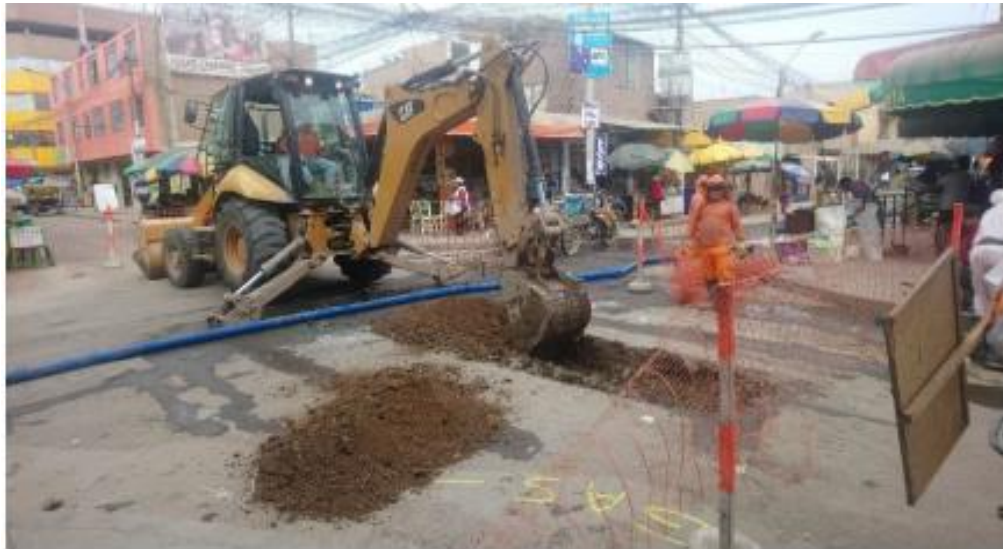
Figura 15: Apertura de Ventanas (Método Cracking)
