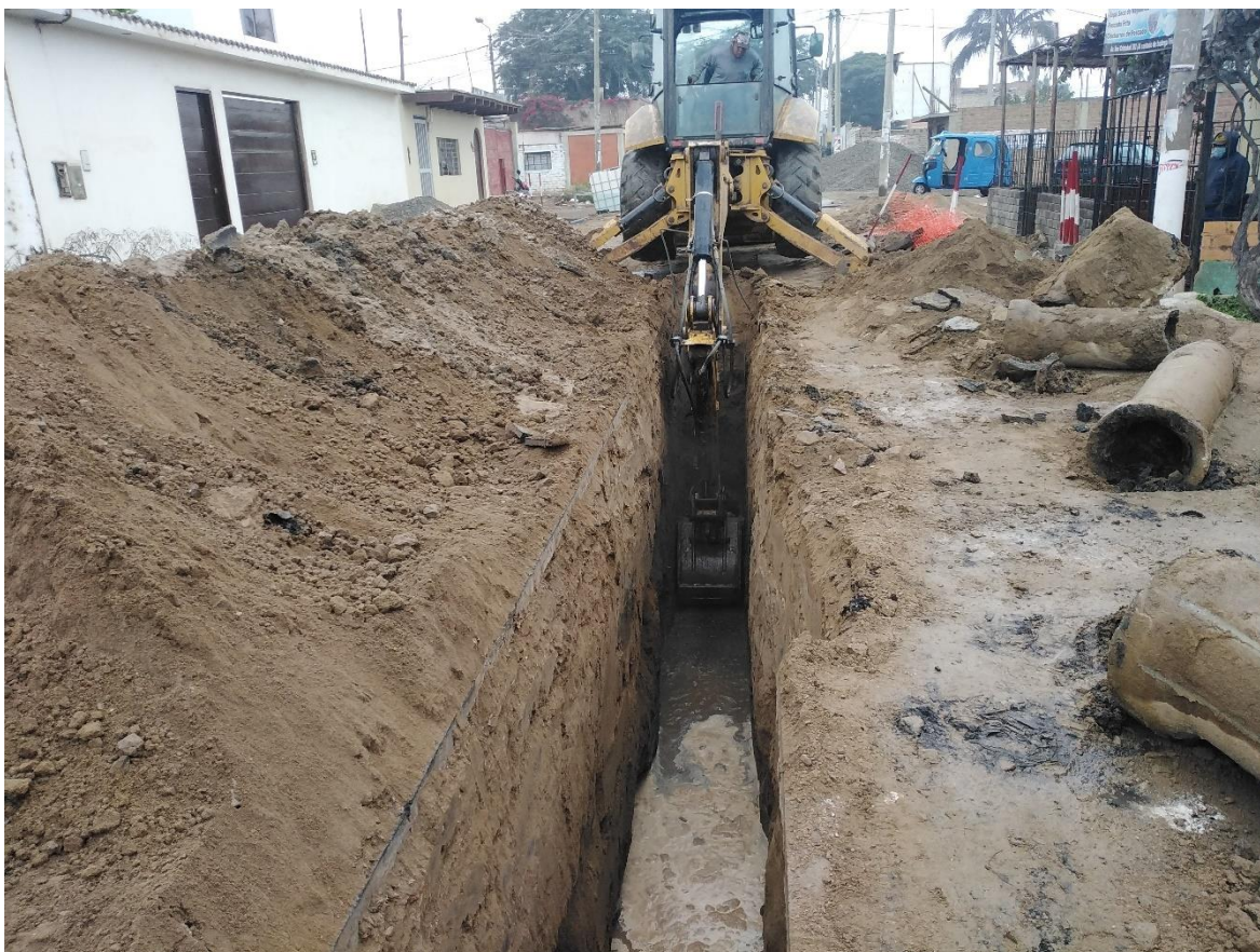
Figura 26: Movimiento de Tierra realizada por el método tradicional
