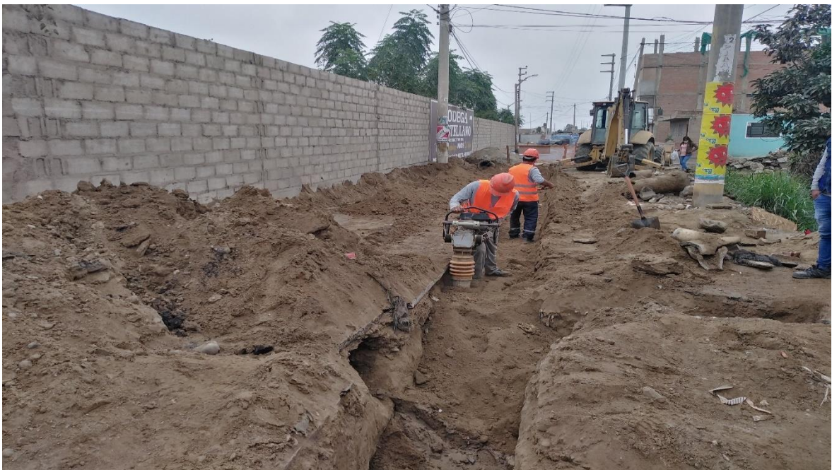
Figura 21: Relleno y compactado (Método Tradicional)
