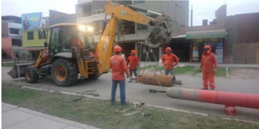
Figura 17: Colocación de Cabezal
