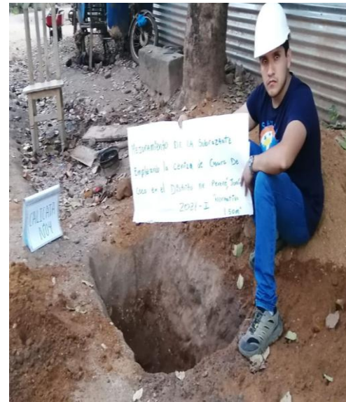
Figura 07: Calicata - 4 Fuente: Elaboración propia 2021
