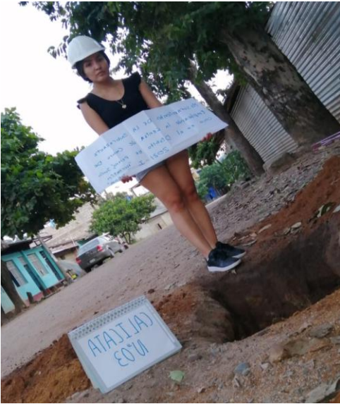
Figura 06: Calicata - 3 Fuente: Elaboración propia 2021
