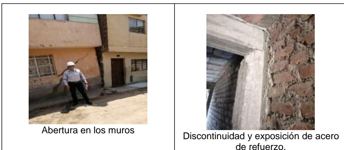
Figura 20. Análisis de elementos estructurales
