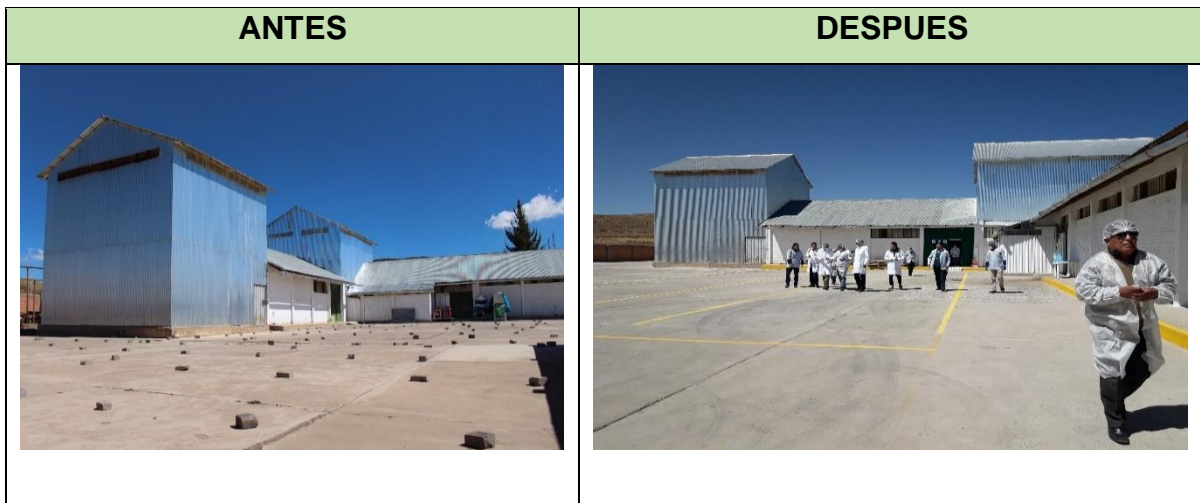
Figura N°28: Estandarización de señalización en playa de secado
