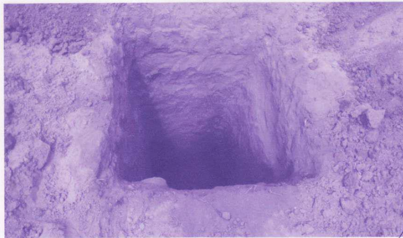
Fotos 12: Vista panorámica de la excavación de la calicata C-06 que conforma el proyecto
