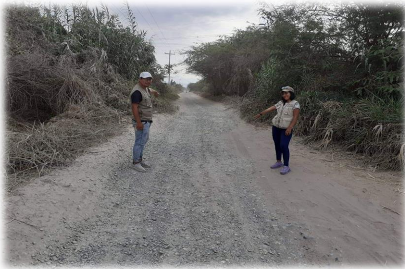
FOTO 15: SE OBSERVA LA EXCAVACIÓN CALICATA C-08.
