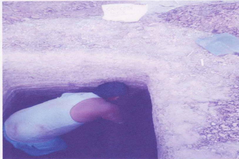
Fotos 08: Vista panorámica de la excavación de la calicata C-04 que conforma el proyecto
