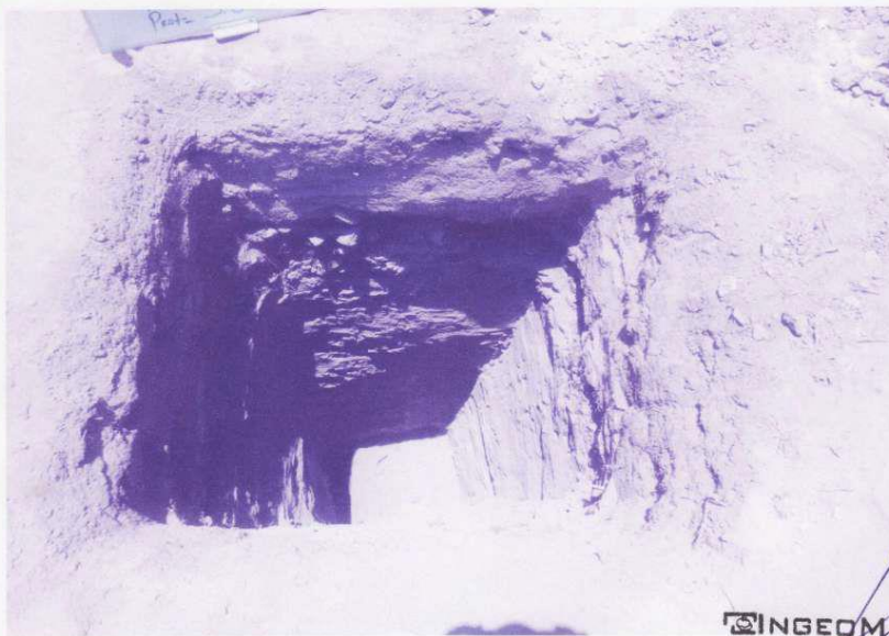
Fotos 16: Vista panorámica de la excavación de la calicata C-08 que conforma el proyecto
