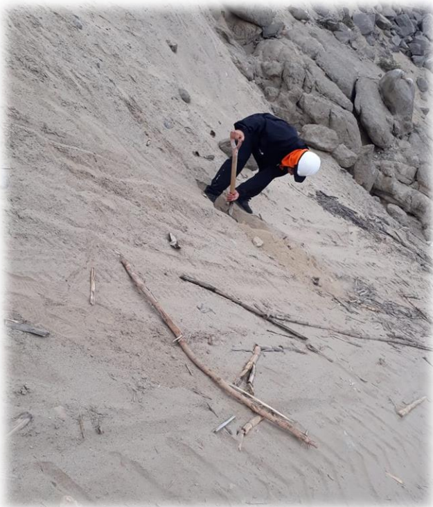
FOTO 13: SE OBSERVA LA EXCAVACIÓN CALICATA C-07.
