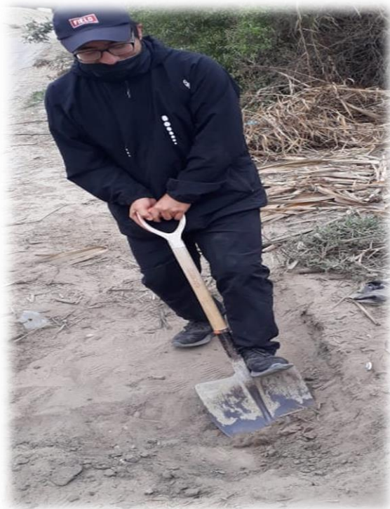
FOTO 09: SE OBSERVA LA EXCAVACIÓN CALICATA C-05.
