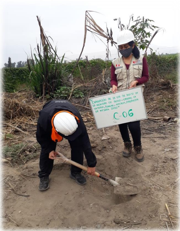
FOTO 11: SE OBSERVA LA EXCAVACIÓN CALICATA C-06.
