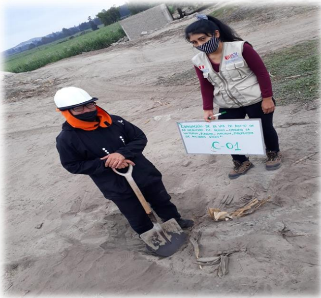
FOTO 01: SE OBSERVA LA EXCAVACIÓN CALICATA C-01.
