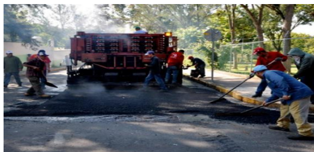
Figura 13. Capa asfáltica Fuente: (Imcyc, 2014)
