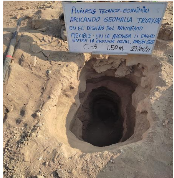
FOTOGRAFIA 6: Calicata N°3, dimensión 1.00mx1.00mx1.50m
