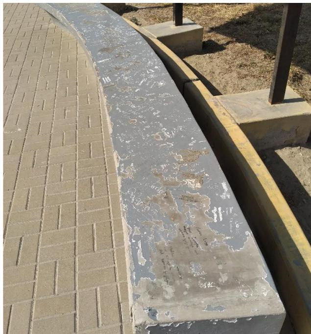
*Figura 6. Falta de mantenimiento de las bancas del parque San Martín – 26 de Octubre. Desgaste de la pintura de las bancas. Marcas gráficas*
