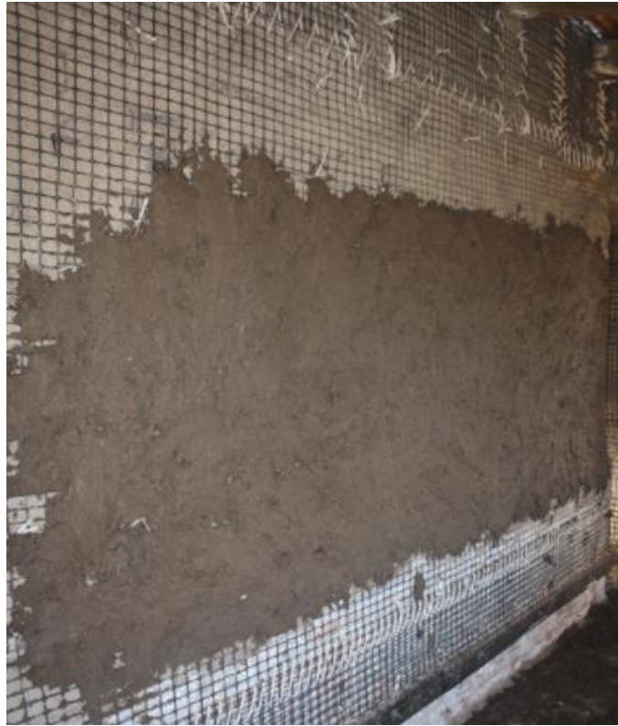
Figura 27: Colocado de Mallas sintéticas y tarrajeo
