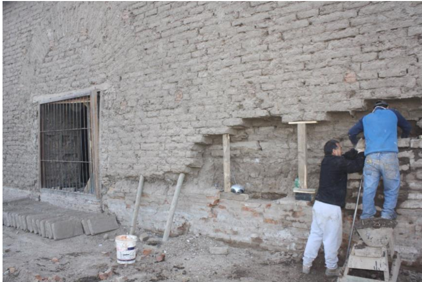
Figura 25: Sustitución de piezas de adobe y reconstrucción del muro
