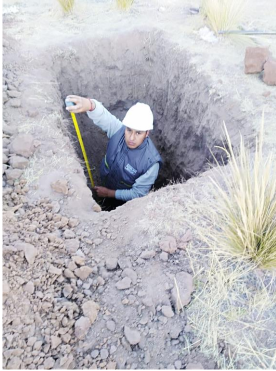
Figura 31: Excavación de la calicata y toma de medidas
