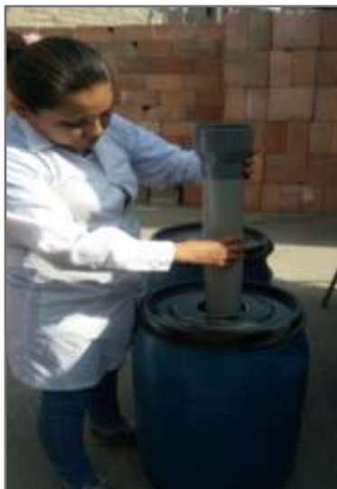
Figura 56 Instalación de la Tubería de Ingreso de Materia Orgánica
