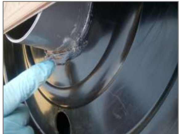
Figura 57 Sellado de los Alrededores de la Tubería
