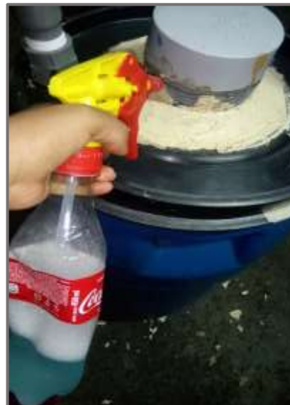
Prueba de Fuga de Aire al Digestor Anaeróbico
