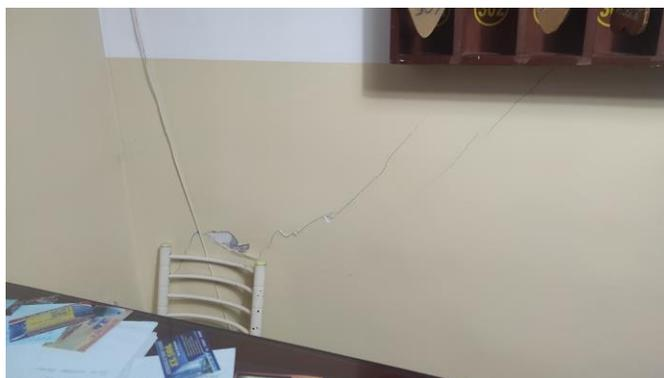
**Foto 03: fisura en los muros a causa de los asentamientos.**
