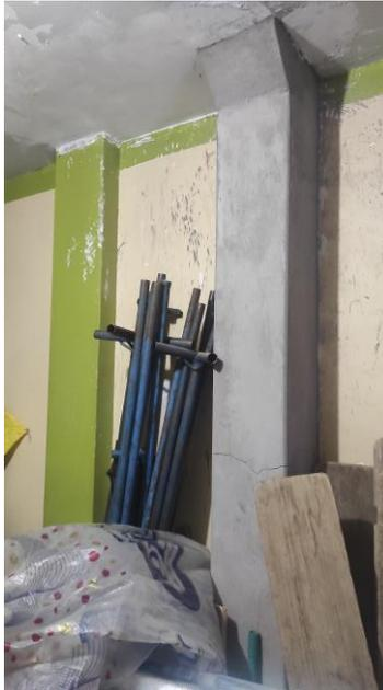
**Foto 01: refuerzo en viviendas dañadas por asentamiento**
