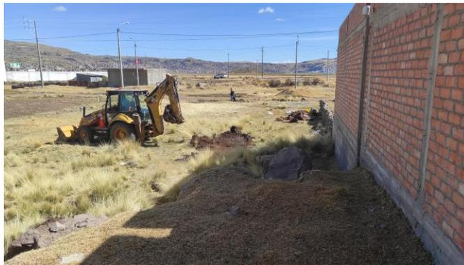
**Foto 05: excavación de calicata 02.**
