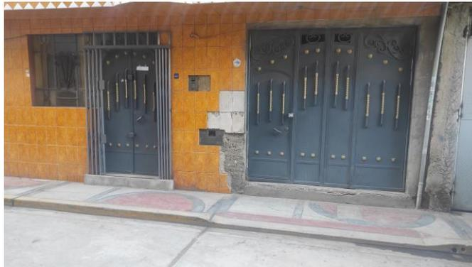
**Foto 02: daño en los acabados a causa de los asentamientos.**
