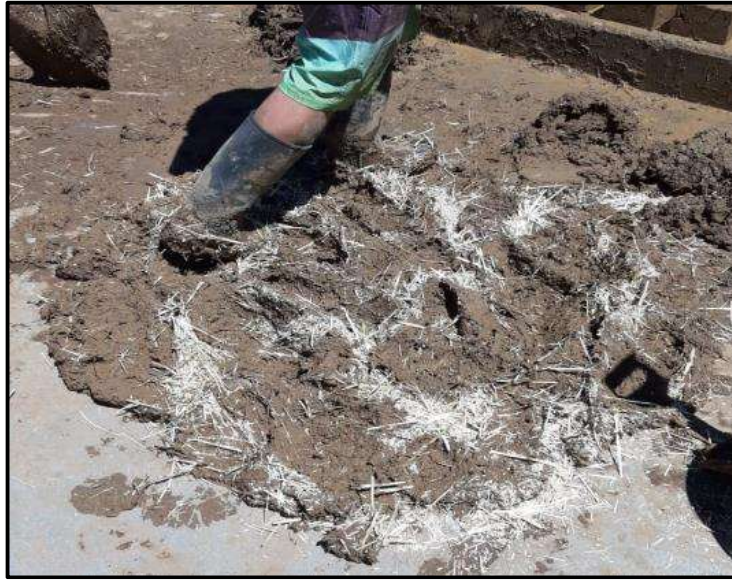
Gráfico 20 Combinación de la mezcla de adobe con paja
