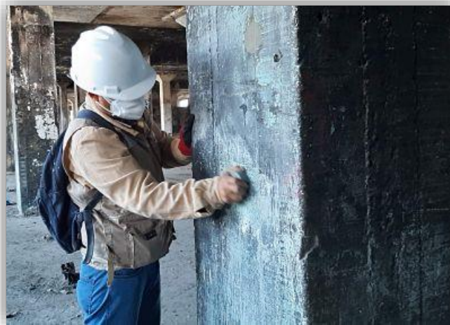
Figura N°71 – Limpieza de superficie
