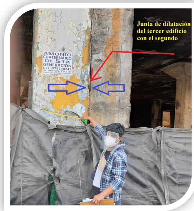
Figura N°15. Junta de dilatación de separación de la edificación Segunda con la Edificación primera
