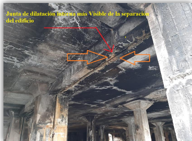
Figura N°16. Junta de dilatación separación interna en la edificación
