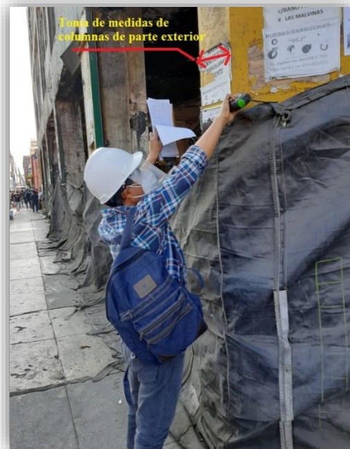
Figura N°20. Toma de medidas de las columnas exteriores
