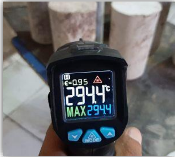
Fisura N°171– Temp. Prob.
