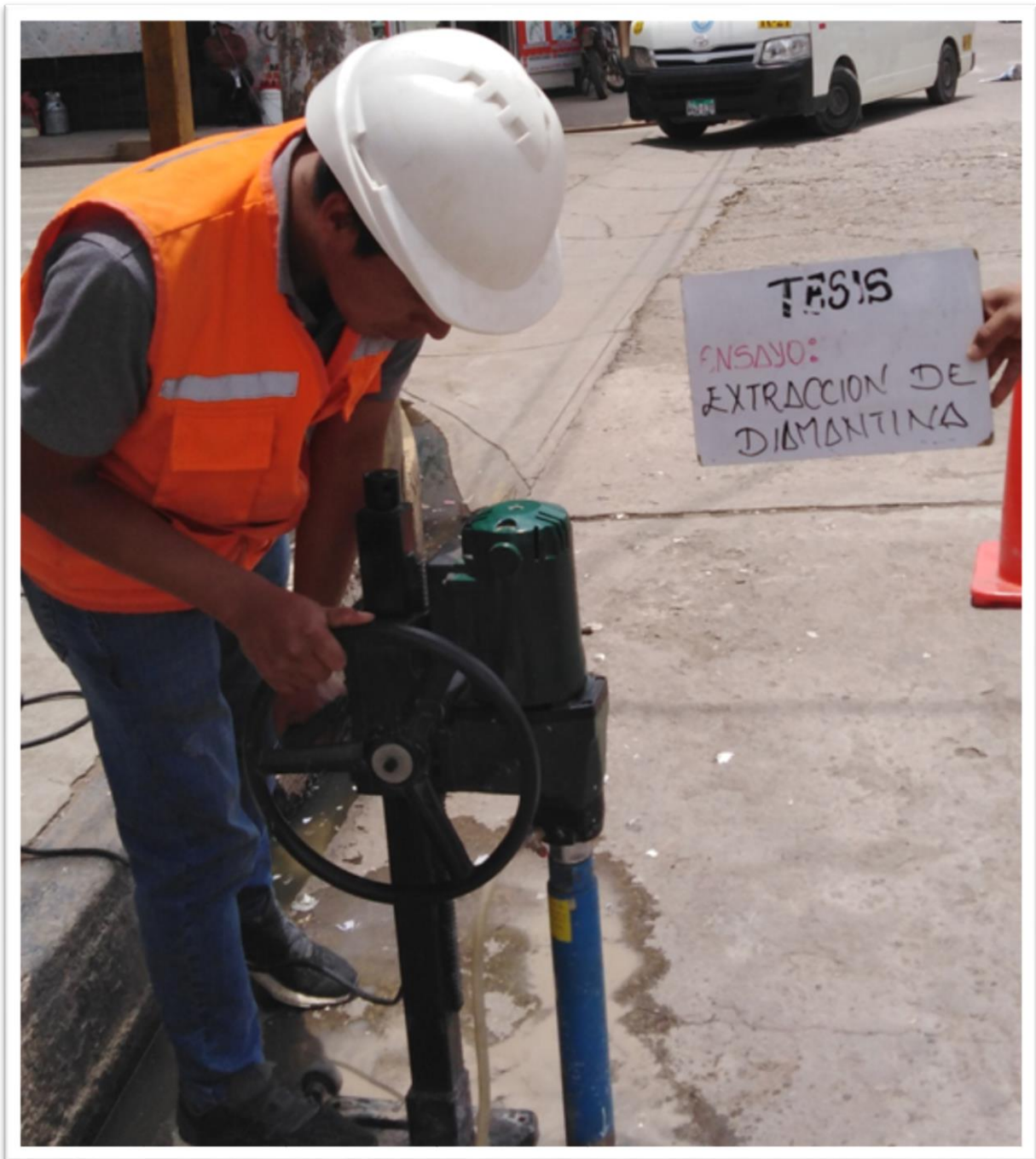
FOTOGRAFÍA 16: ENSAYO DE EXTRACCIÓN DE DIAMANTINA
