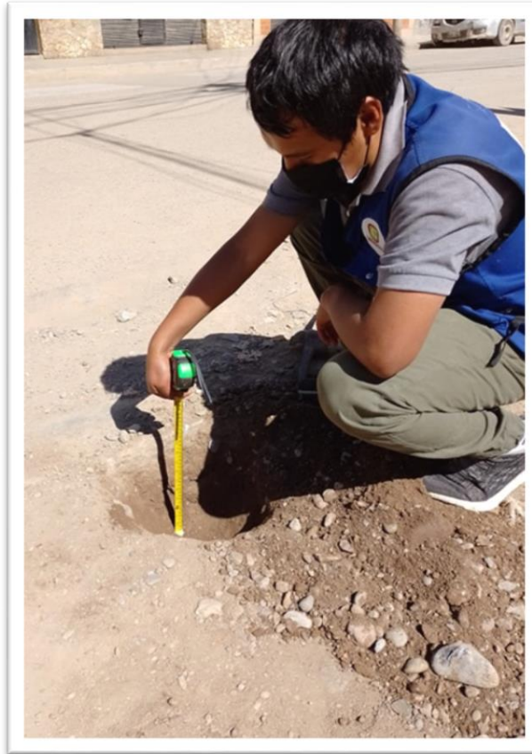
FOTOGRAFÍA 12: MIDIENDO LA CALICATA
