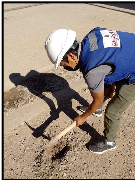
Ilustración 6: Empezando a realizar las calicatas. Fuente: Elaboración propia
