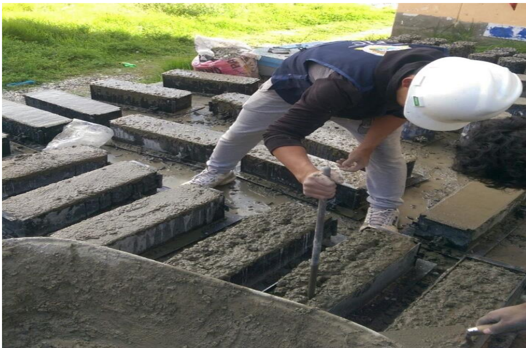
Foto N° 12: colocado de concreto en moldes de vigas
