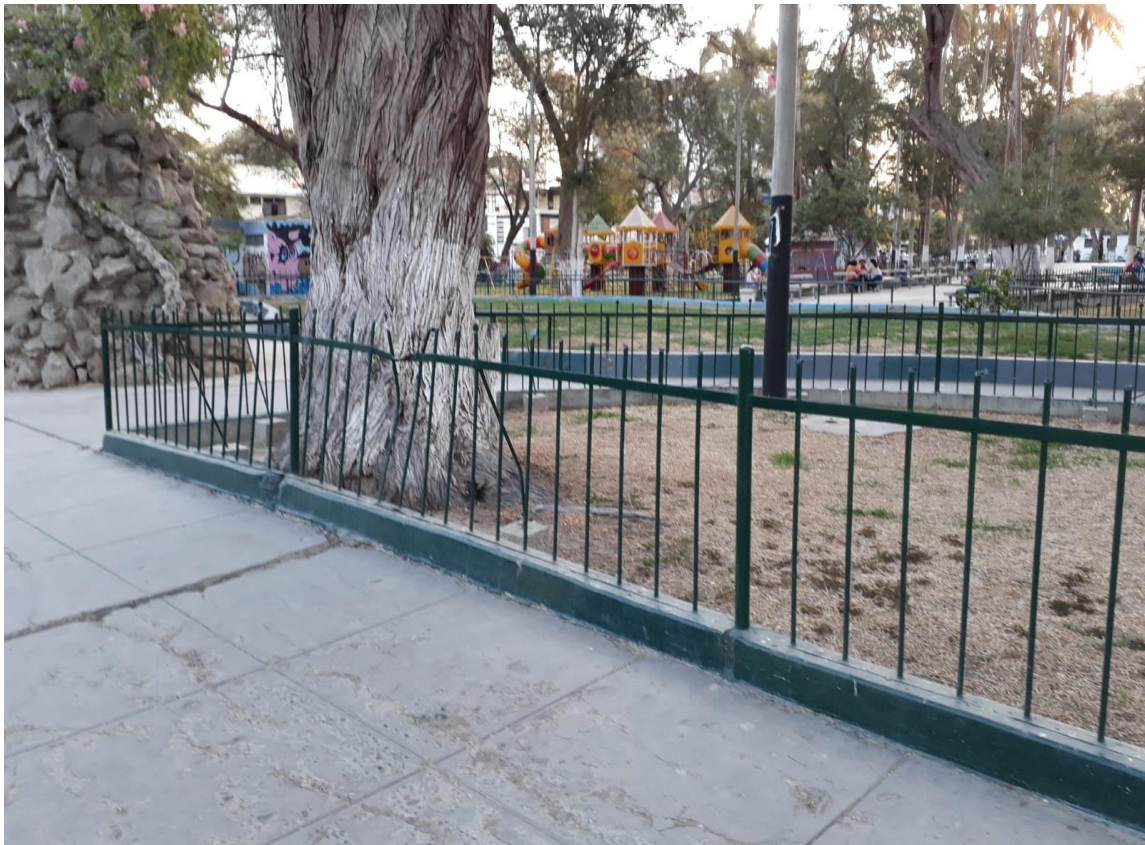
Figura 2. Mantenimiento inadecuado de la vegetación
