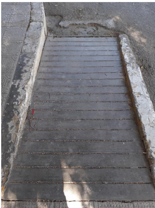
Figura 1: Rampa de acceso a la plaza Tres Culturas del distrito de Piura - Jr. Moquegua.
