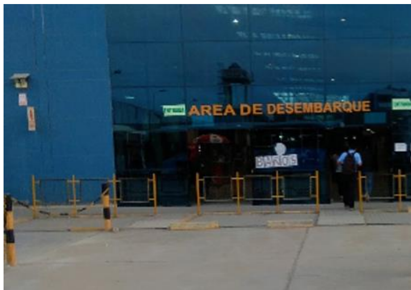
Figura N°02: Zona de desembarque, falta de señalización para personas con discapacidad. Empresa Gechiza. Piura, 2020.
