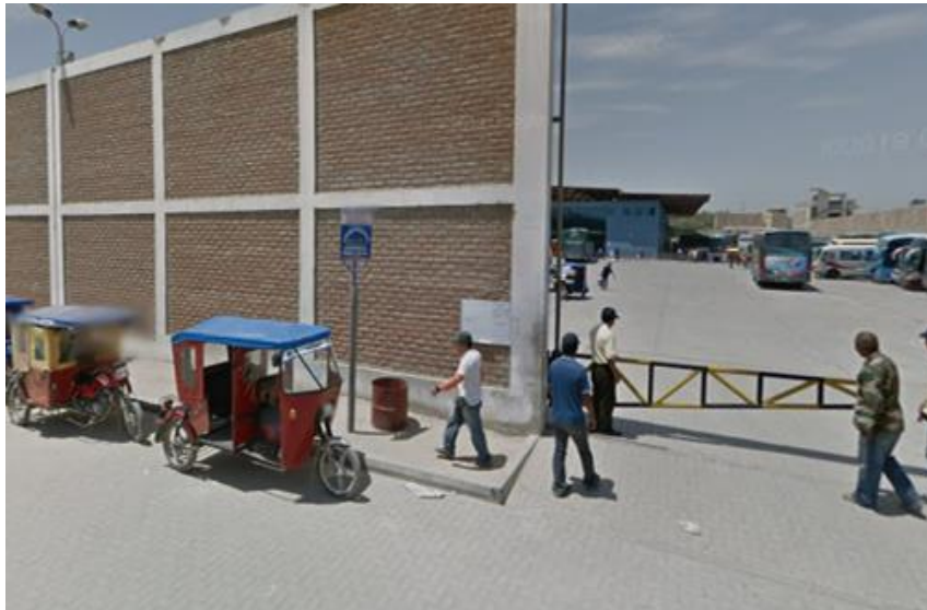
Figura N°04: Inexistencia de rampas o espacios señalizados. Empresa Gechiza. Piura, 2020.
