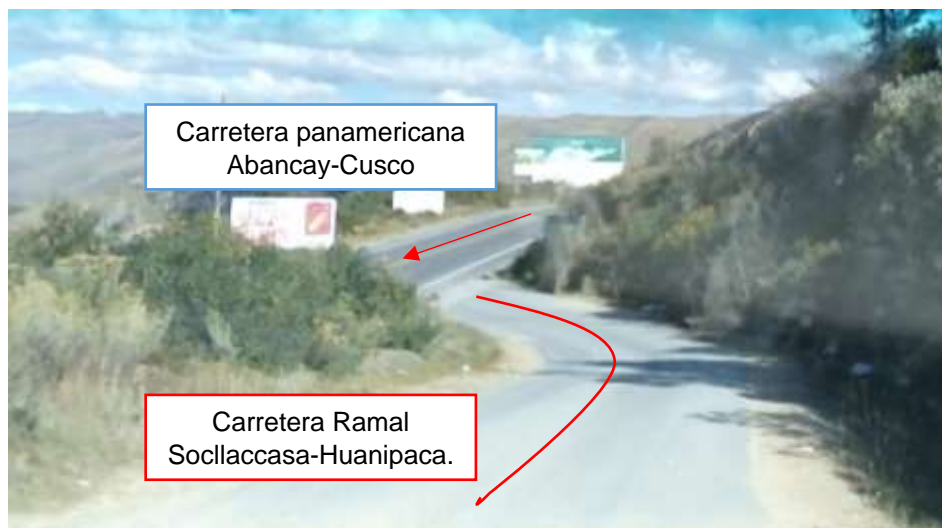
Figura 1. Se observa el ramal de la carretera Soclaccasa – Huanipaca.
