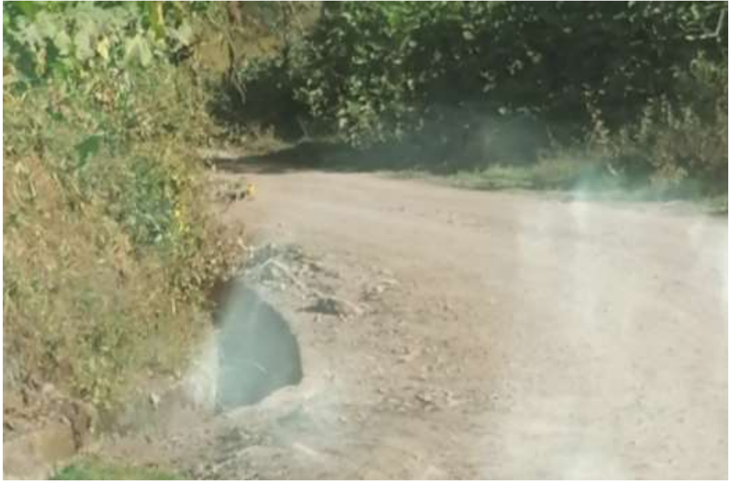
Figura 7. Se puede observar en algunos tramos de la vía que las cunetas y alcantarillas se encuentran deterioradas y llenas de piedras y basura que impiden la adecuada circulación del agua.
