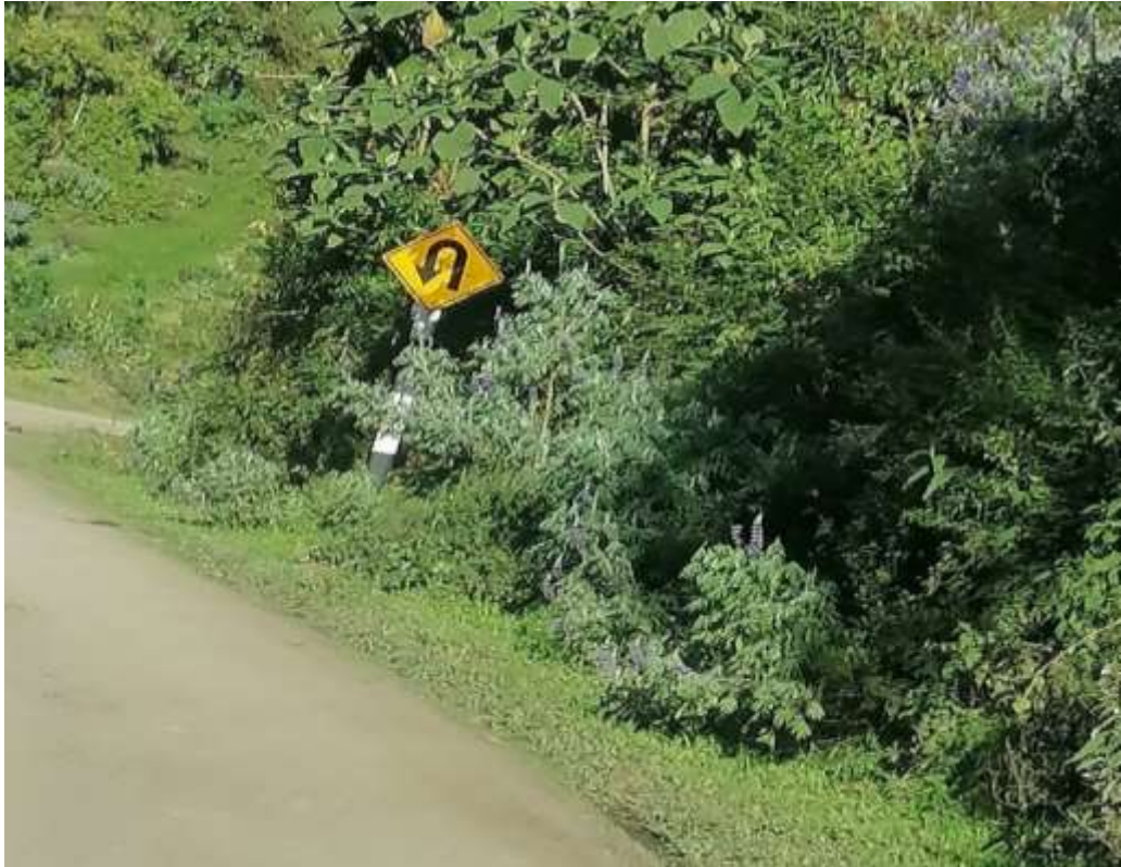
Figura 5. Se puede observar en algunos tramos de la vía que hay abundante vegetación que obstaculiza la visibilidad de las señales de tránsito.
