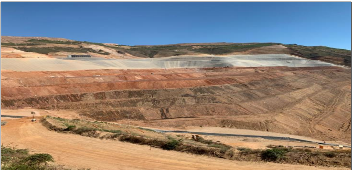
Fotografía 16: Pad de Lixiviación N° 2
