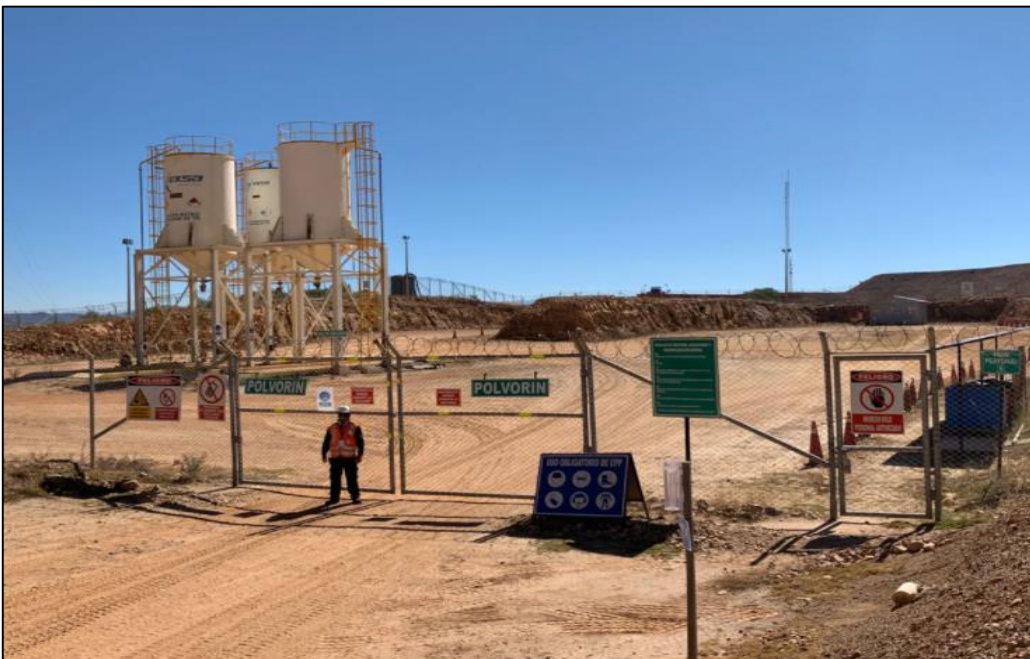
Fotografía 8: Polvorín (almacén de explosivos) Shahuindo
