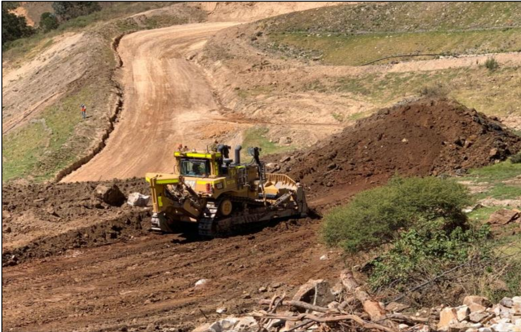
Fotografía 5: Stripping de suelo orgánico
