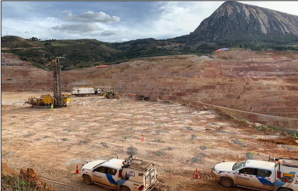
Fotografía 9: Carguío de explosivos
