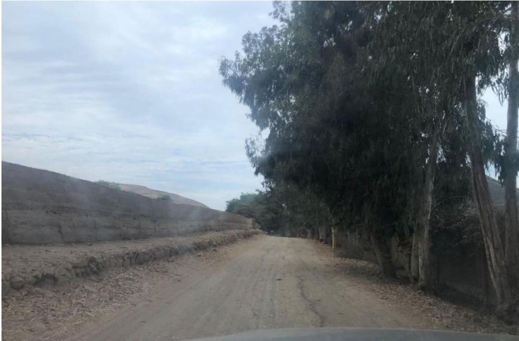
Fotografía 1. Reconocimiento de terreno
