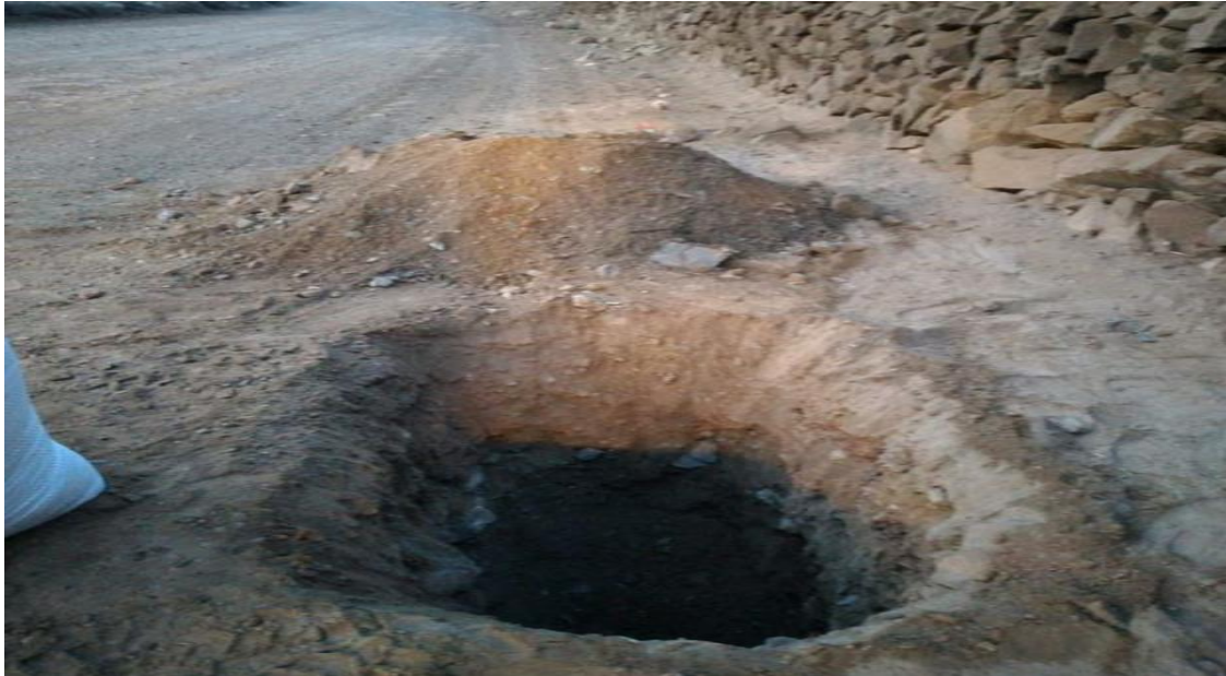
Fotografía 3. Excavación de calicatas
