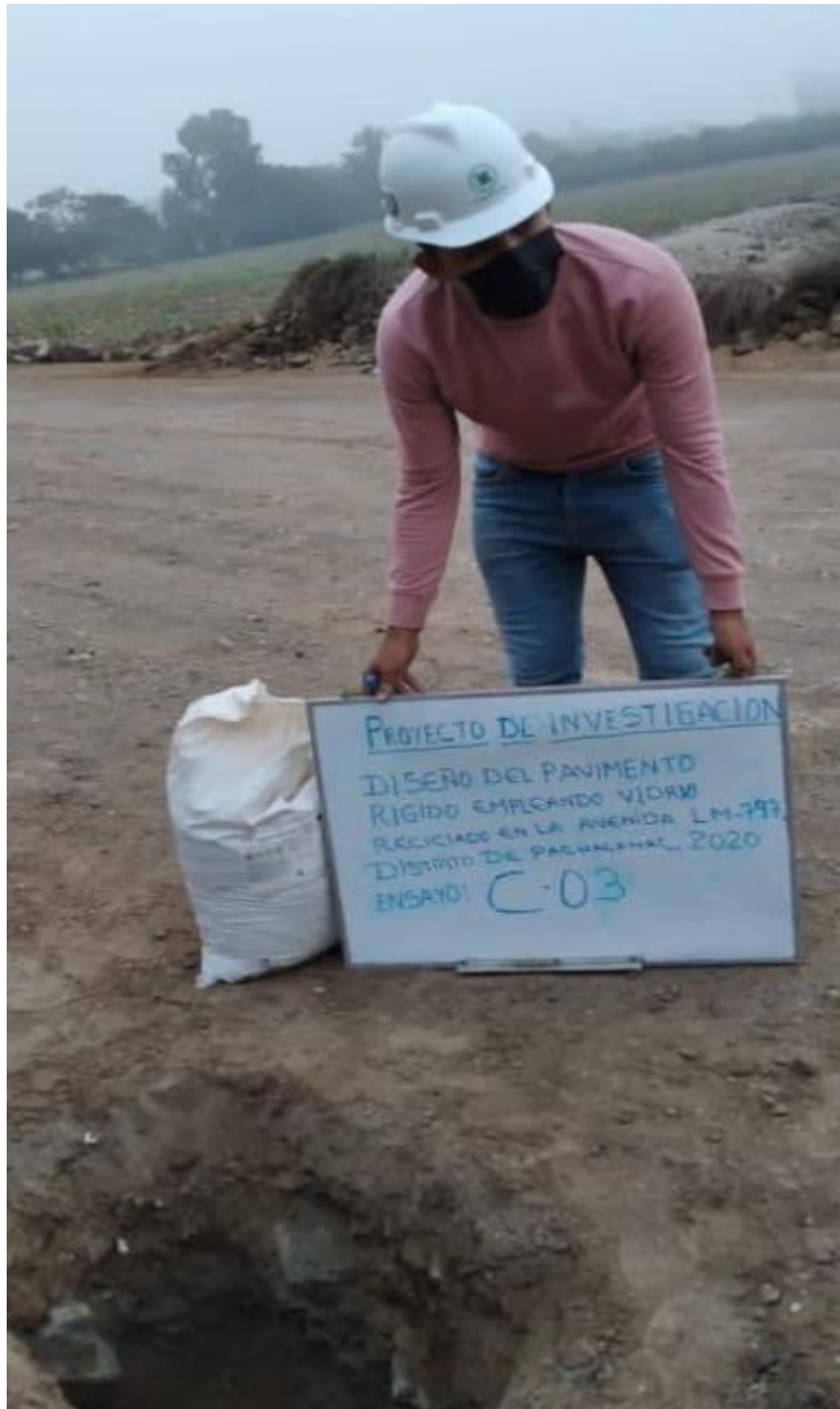
Fotografía 7. Extracción de la muestra de la calicata- 03.
