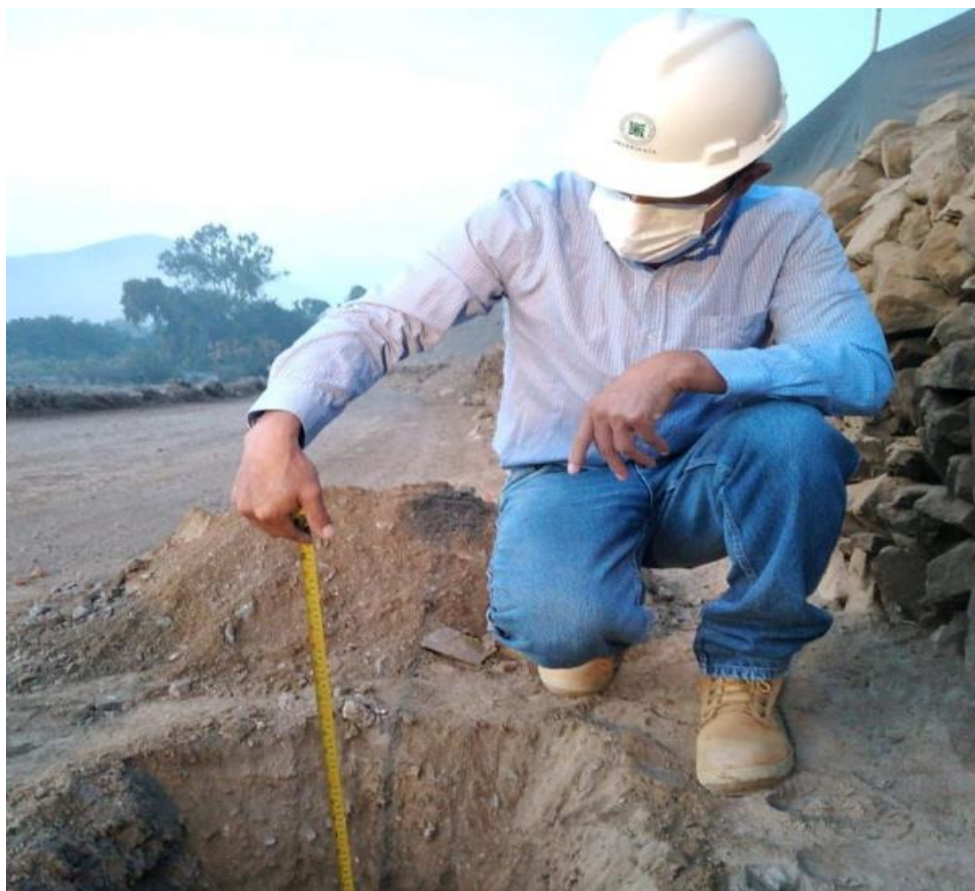
Fotografía 4. Excavación de calicatas.
