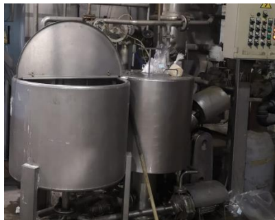
Figura N° 12: Tanques de almacenamiento
