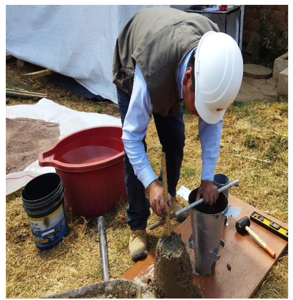
Fotografía 04: Determinación de Slump
