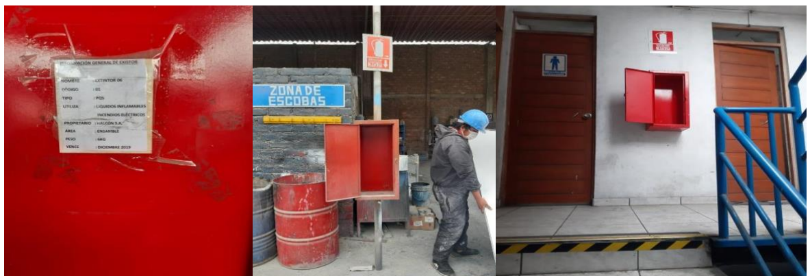
Figura 53. Inspección de Extintores
