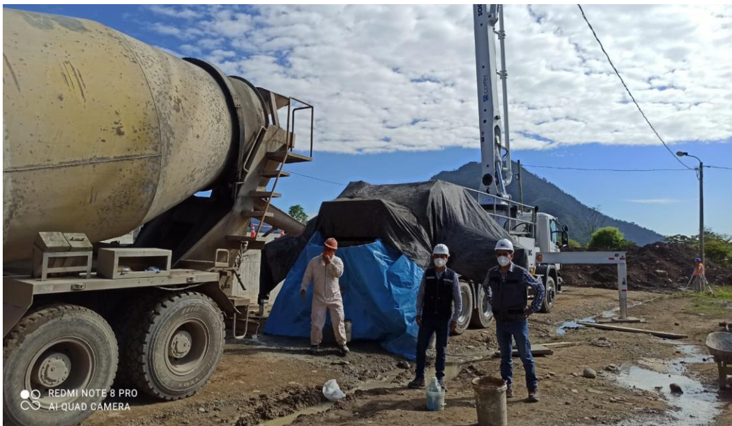
Ilustración 14.- Concreto pre - mezclado con adición de superplastificante
