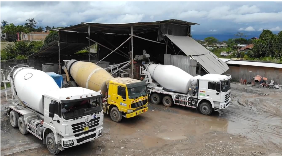
Ilustración 8.- Planta procesadora de concreto premezclado
