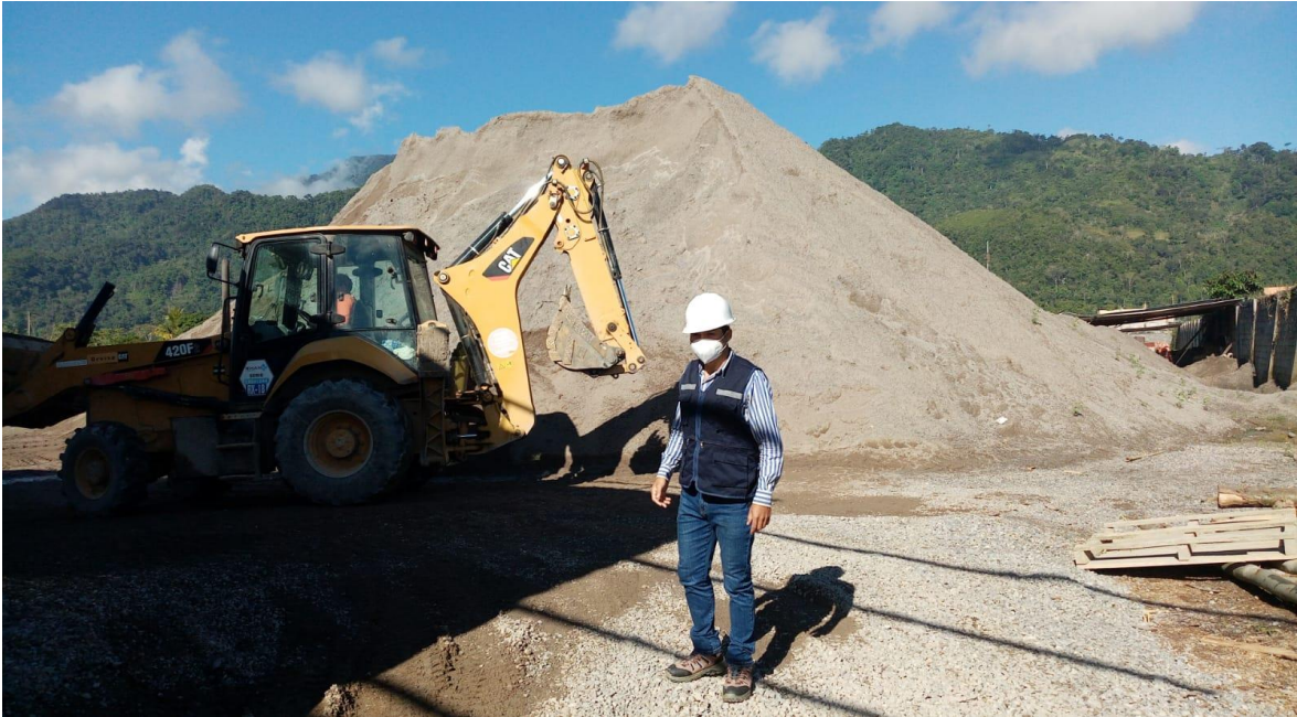
Ilustración 7 Materia prima, agregados para el concreto
