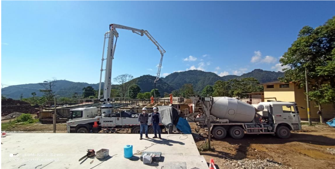
Ilustración 16 Concreto pre - mezclado listo para ser bombeado
