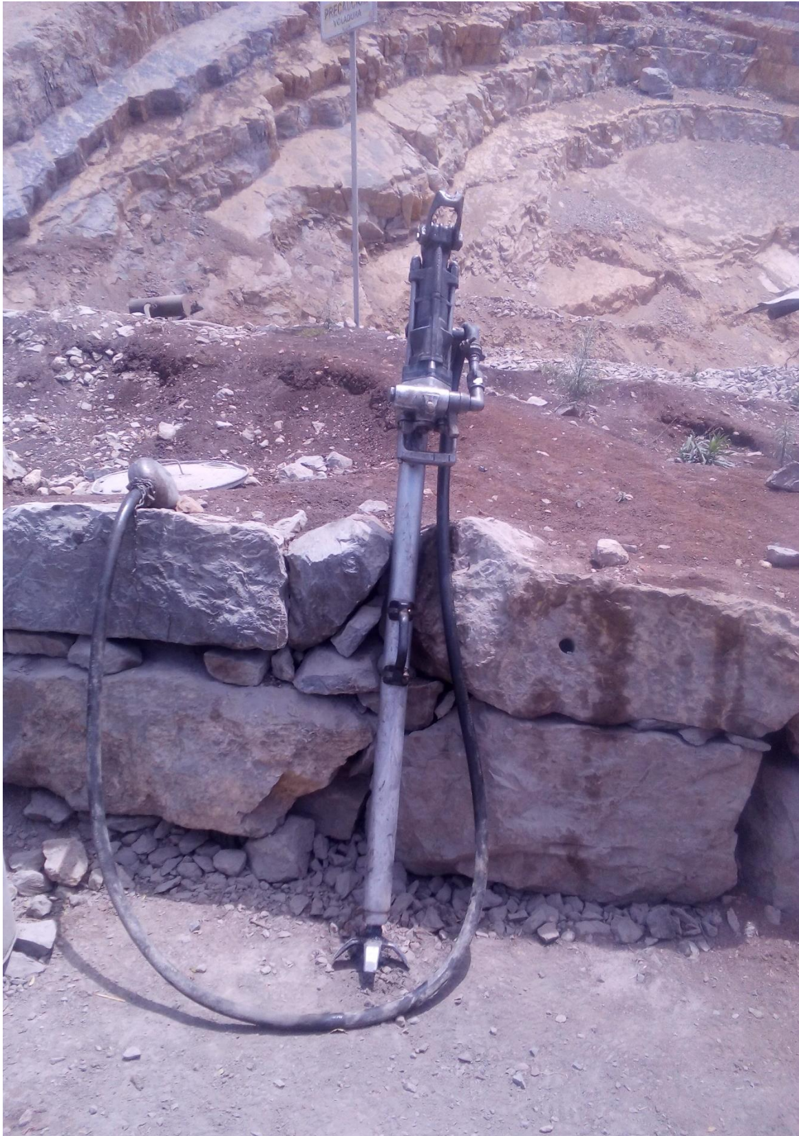
Figura 5: Máquina perforadora Jackleg. Fuente: Fotografía tomada insito calera bendición de Dios.
