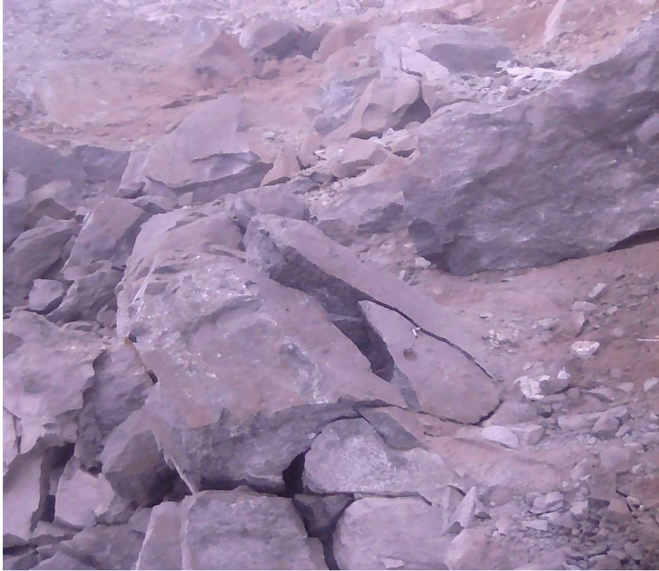
Figura 8: Resultados después de la voladura. Fuente: Fotografía tomada ínsito calera bendición de Dios.
