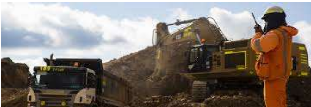
Foto 4: Equipo de carga cargando material tajo Pampa Verde.
