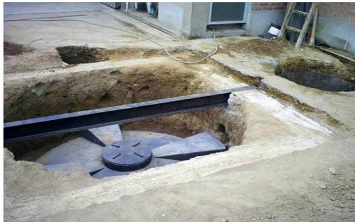
Cuando exista una pendiente pronunciada es importante proyectar una caja previa, de tal manera que pueda disiparse la presión del afluente y no genere disturbación dentro del biodigestor.
