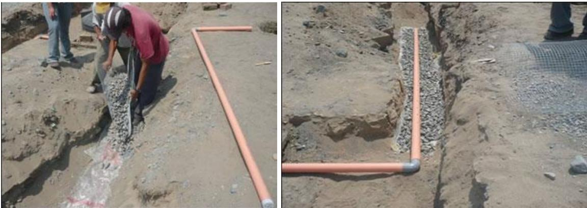
Vista de las tuberías en la zanja de infiltración.
