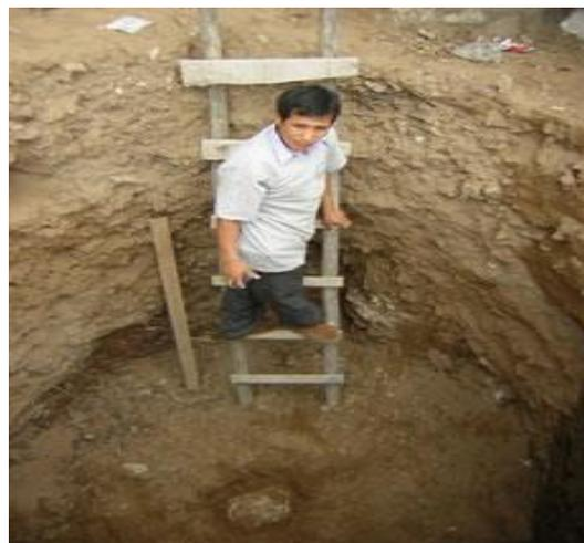
Biodigestor de 3,000 litros.
