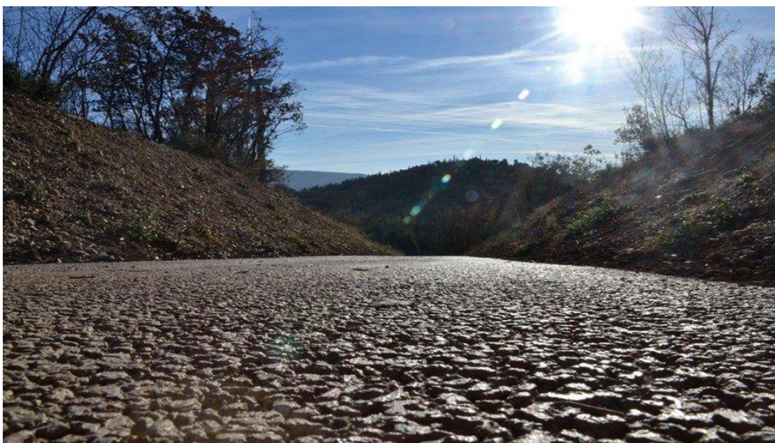
Figura 05. Concreto permeable como capa de rodadura
