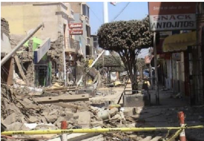
Figura 2. Daños estructurales en la ciudad de Ica luego del sismo 2007.
