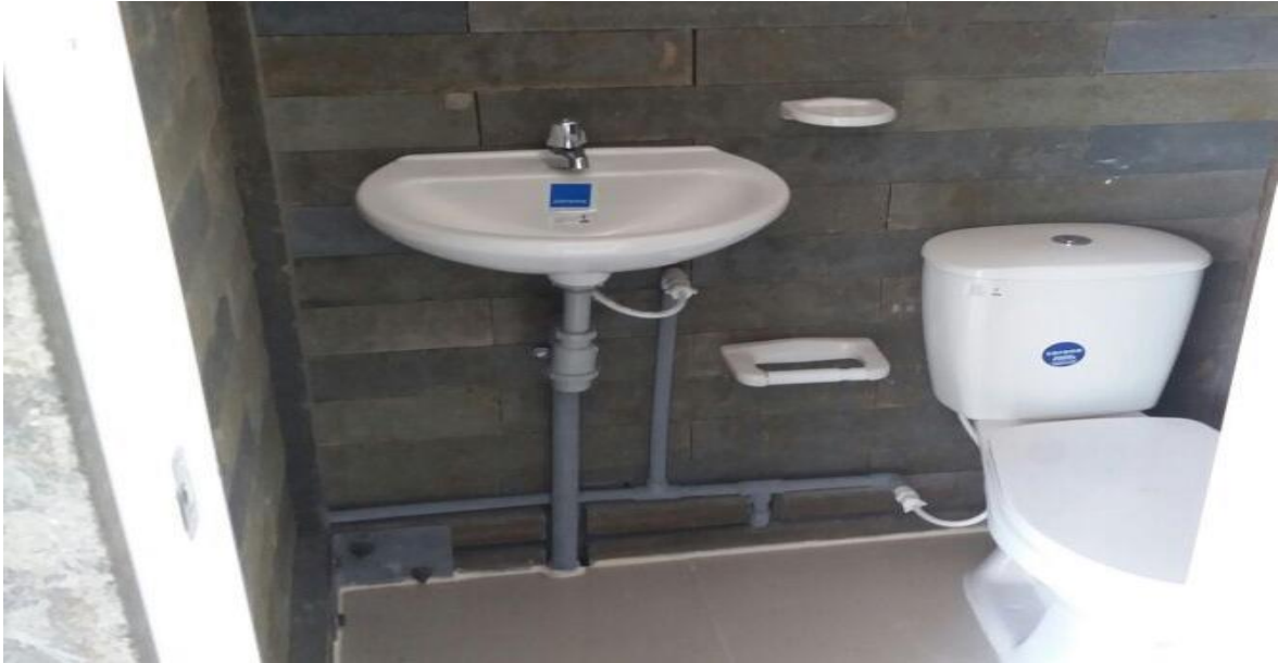
Vivienda unifamiliar a base de plástico reciclado
