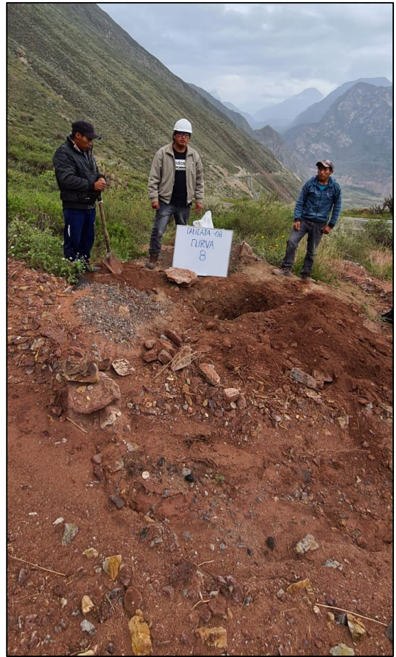
Foto 02: Calicata realizada en ZG - 01
