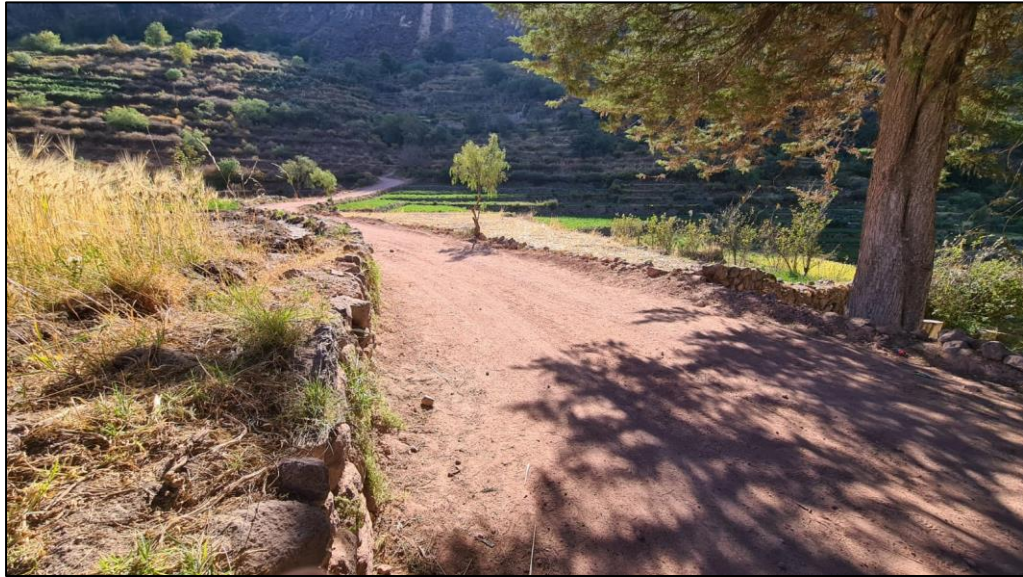
Foto 06: Vista de subrasante arcillosa en Siringay, Arequipa.
