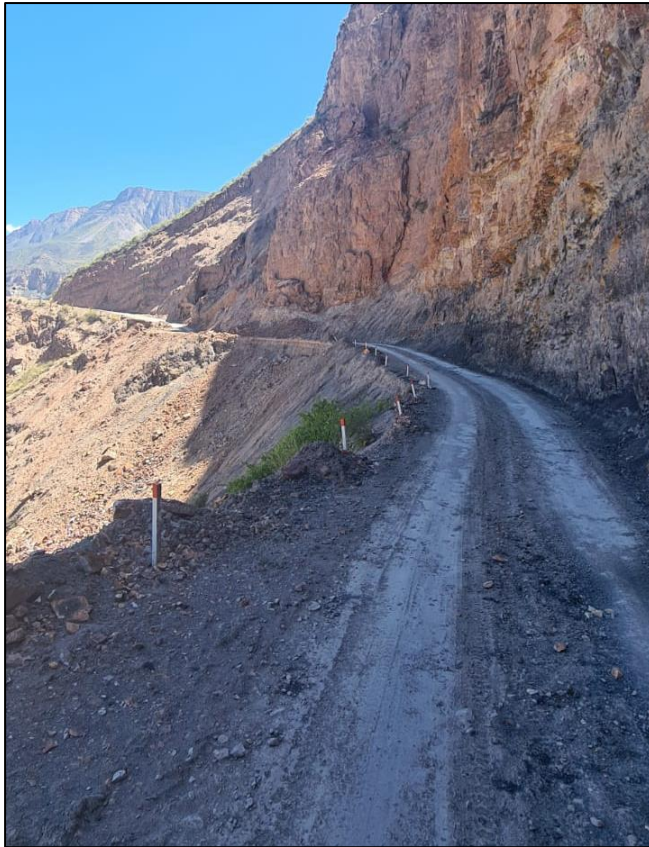
Foto 04: Vista de calzada en ZG - 02.
