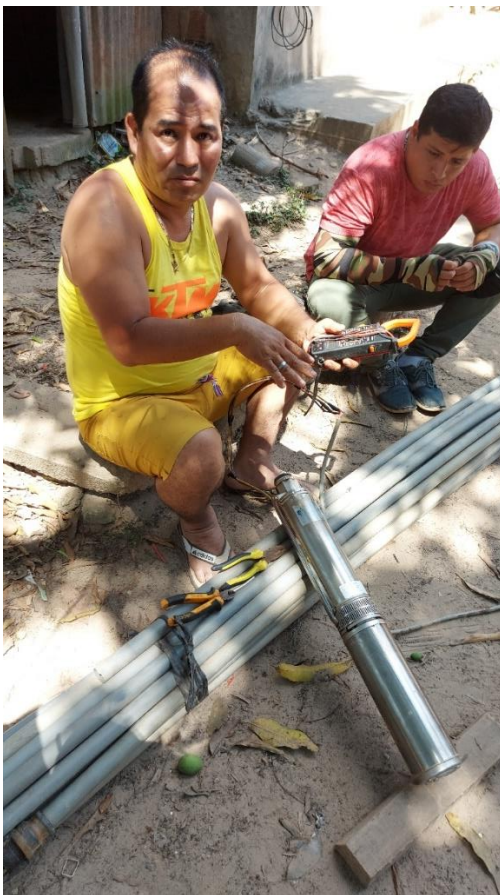
❖ Limpieza y mantenimiento de tanque elevado, pozo tubular y bomba sumergible , se observan los trabajos manuales de limpieza y mantenimiento a tanque elevado y pozo tubular, ubicado en el Km 6 margen derecho por Shirambari, interior 4 km.
