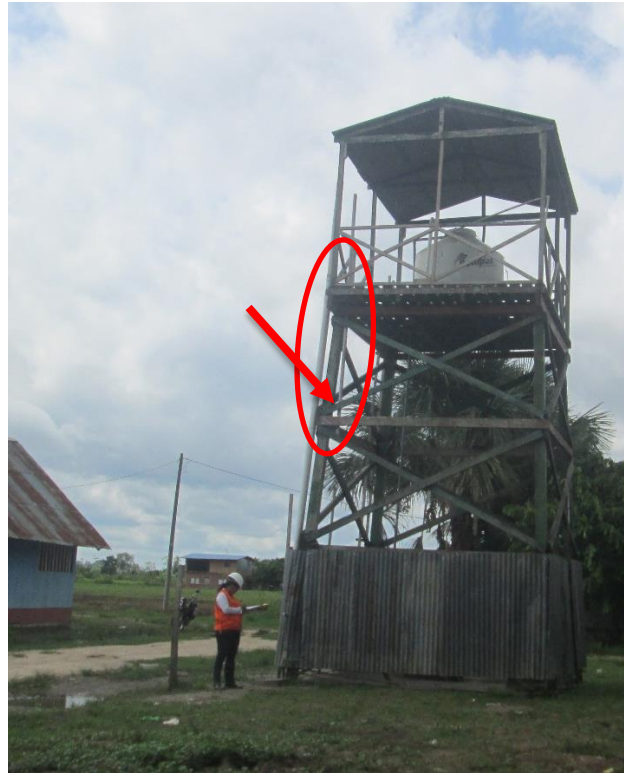
La tubería que se observa es la línea de limpieza, y se encuentra suspendida aproximadamente a 3.50 metros.
