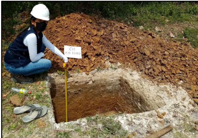
Figura 23: Las Guineas- Mañumal, Excavación de Calicata 14 (km. 7+000), por extracción de muestra de suelo, evidencia fotográfica, 2021.
