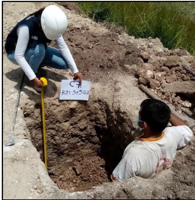
Figura 17: Las Guineas- Mañumal, Excavación de Calicata 7 (km. 3+500), por extracción de muestra de suelo, evidencia fotográfica, 2021.
