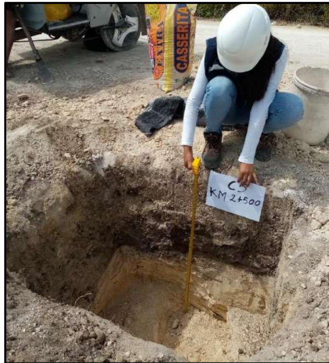
Figura 15: Las Guineas- Mañumal, Excavación de Calicata 5 (km. 2+500), por extracción de muestra de suelo, evidencia fotográfica, 2021.
