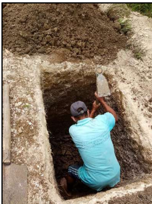
Figura 21: Las Guineas- Mañumal, Excavación de Calicata 12 (km. 6+000), por extracción de muestra de suelo, evidencia fotográfica, 2021.
