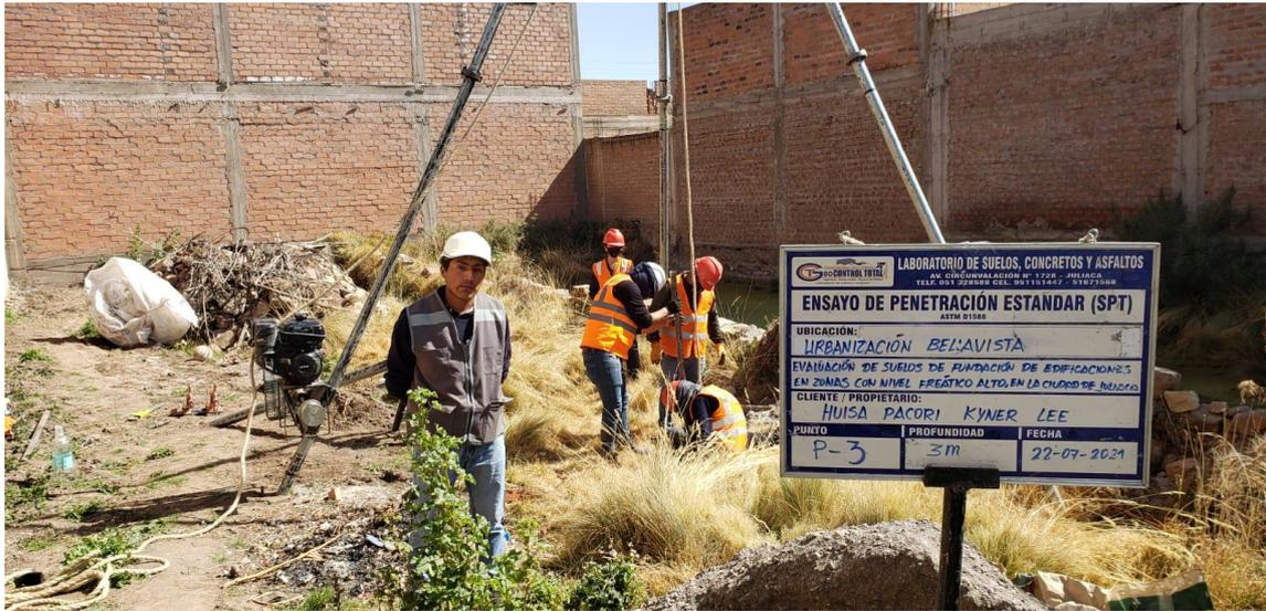
**Fotografía 03.** Ejecución de prueba SPT-3.
